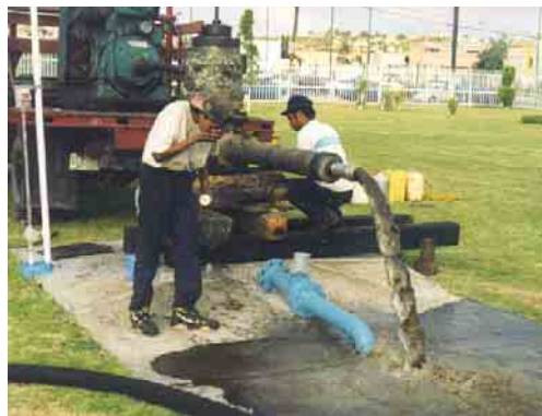
Figura 4.8 Vista del equipo para la prueba de aforo; determinando el tiempo de abatimiento y recuperación del tirante de gasolina.
