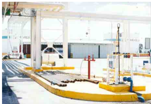
Figura 4.11 Pozo de extracción con la bomba de bajo gasto instalada.
