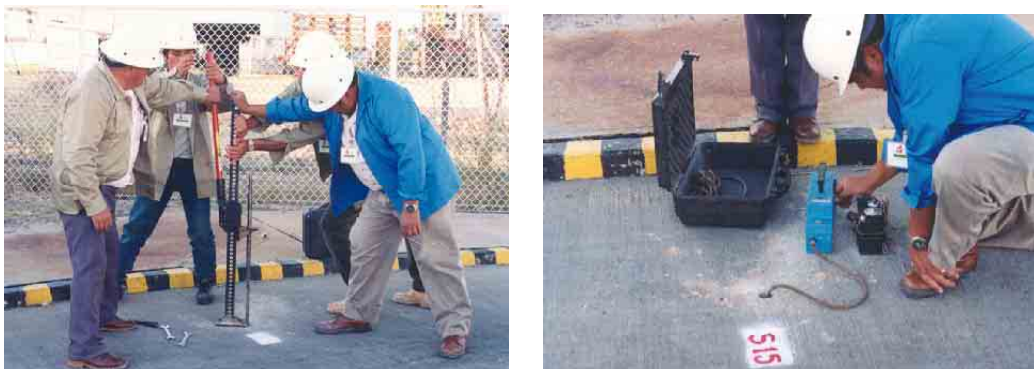
Figura 4.5 Perforación y medición de la concentración de hidrocarburos volátiles y explosividad.
