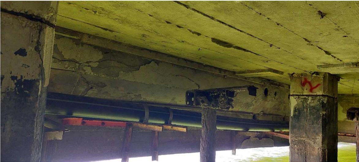
**Figura 1.2 Instalación horizontal de ducto de gas, en muelle de descarga, instalación con ángulos y tuercas y birlos fijados a la pantalla del muelle**
