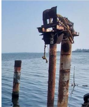
b) Corrosión metálica de estructuras metálicas expuestas a la intemperie
