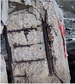
a) Corrosión del acero embebido en concreto.
