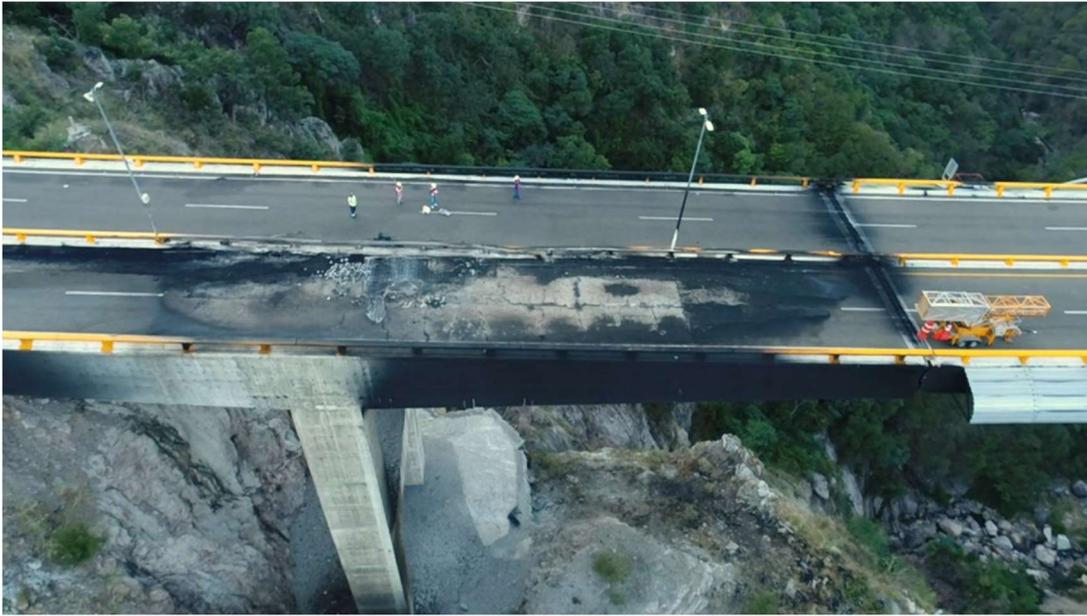
**Figura 1.4 Vista general de la sección doble voladizo del puente El Carrizo posterior al incendio**
