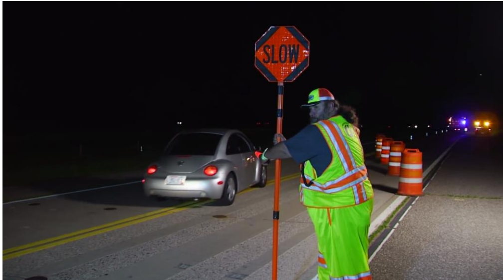
Figura A3.11 Control de tránsito con bandereros durante la noche
