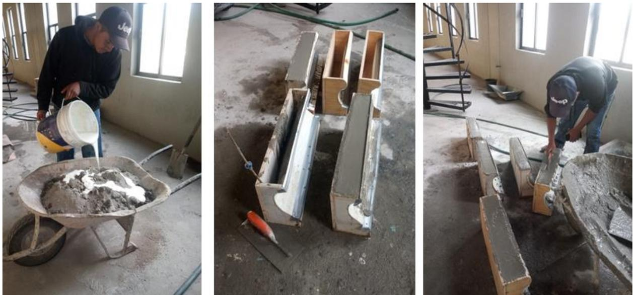
Figura 5.5 Proceso de colado de los deflectores de oleaje a ensayar
