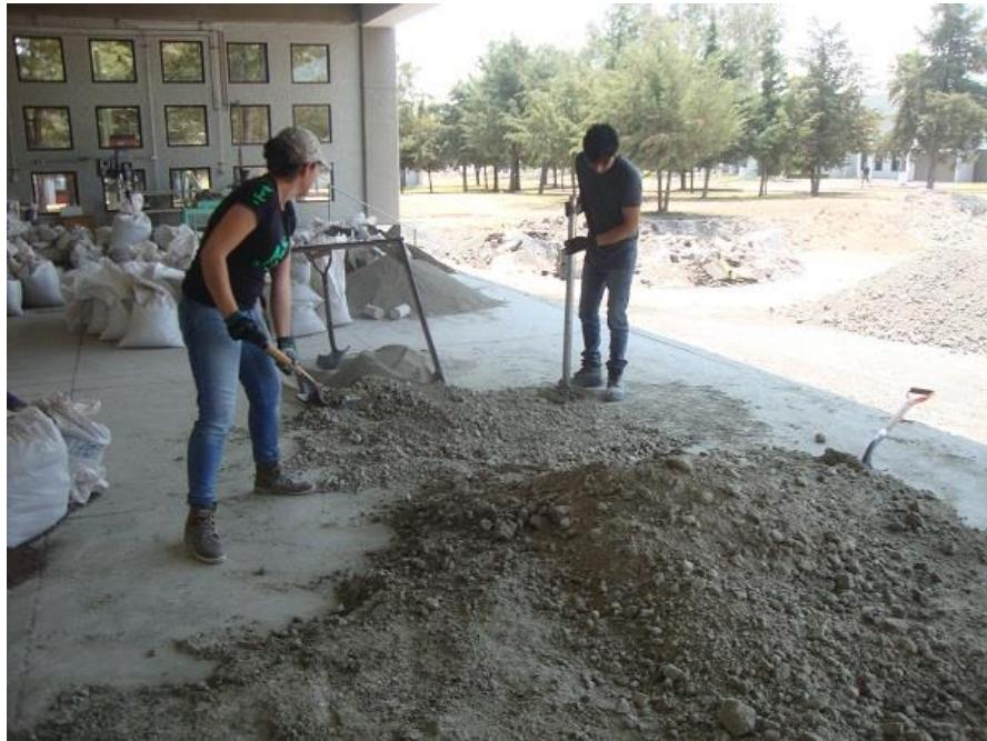
**Figura 1.4. Cribado de material por la malla No. 4**
