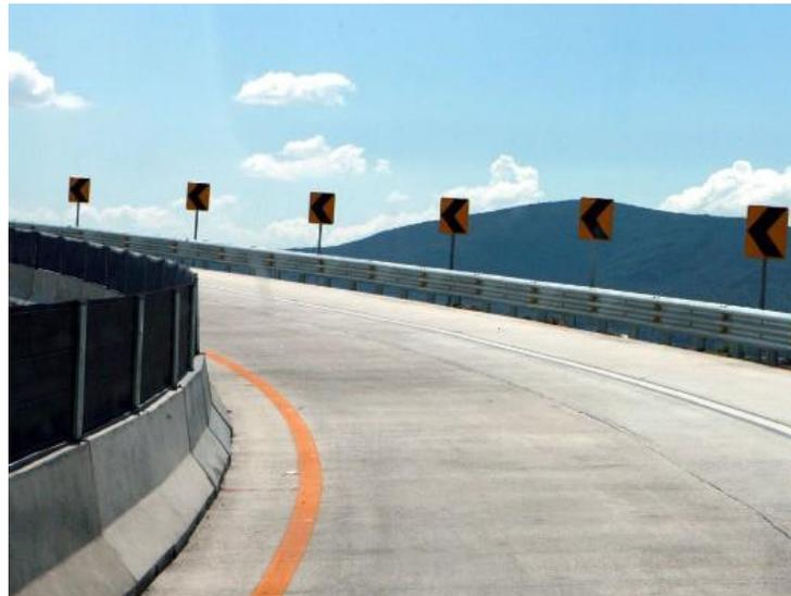
**Figura 4.15 Pantalla antideslumbramiento en la barrera central.**
