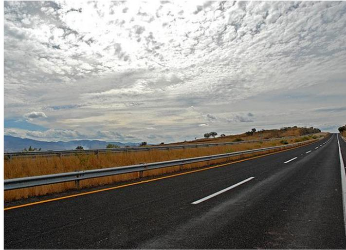
**Figura 4.16 Ejemplo de barrera a los costados de la vía.**
