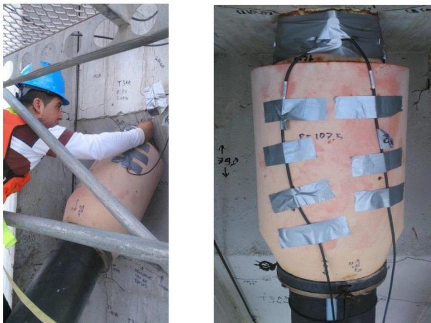
**Figura 1.15 Procedimiento de colocación y fijación de sensores.**
