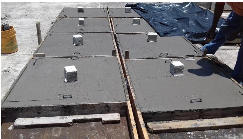
**Figura 2.10. Acabado final de las losas antes del periodo de curado**
