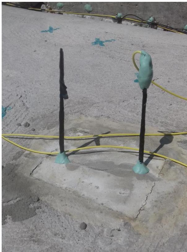
Figura 2.15. Conexión eléctrica de ánodo
