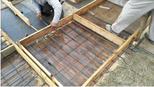
**Figura 2.5. Fabricación de moldes**
