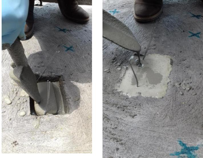
**c)** Colocación de ánodo      **d)** Ánodo embebido
