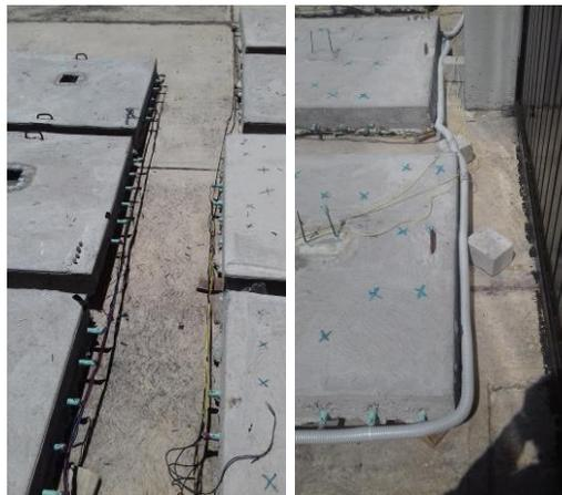
**Figura 2.12. Conexión de las losas y protección de los cables**
