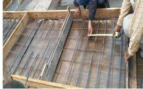
**Figura 2.6. Colocación de las barras de acero de acero**
