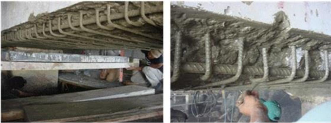
**Figura 1.10 Colocación del puente de adherencia en el refuerzo y la superficie de concreto**
