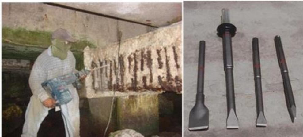
**Figura 1.5** Equipo recomendado a usarse en la demolición y tipo de puntas de demolición requeridas
