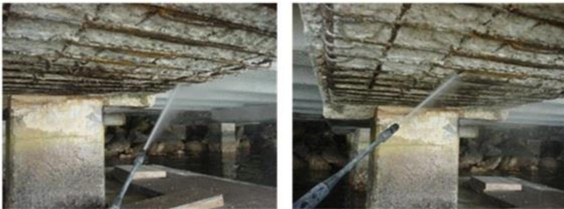
**Figura 1.9 Limpieza con chorro de agua, nótese que la demolición del concreto debe cumplir una profundidad constante**
