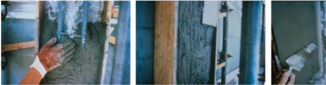
**Figura 1.11 Procedimiento de reparación con mortero predosificado y tixotrópico en casos donde la demolición posee un espesor de 3 cm o menor (REHABILITAR, 2003)**
