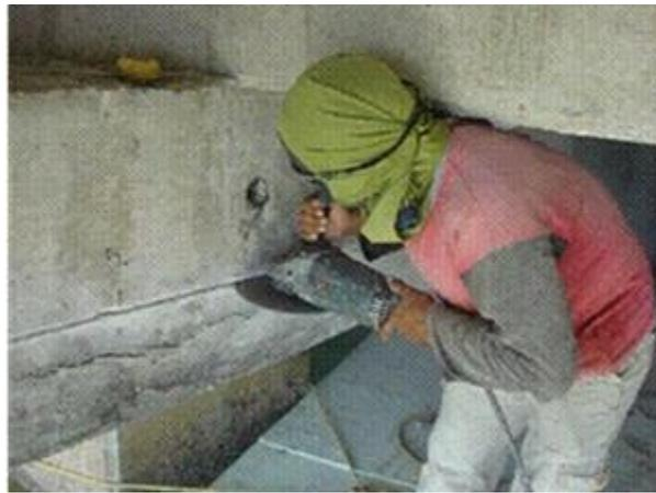
**Figura 1.4 Cortadora eléctrica manual y ejemplo de delimitación de la superficie a demoler**
