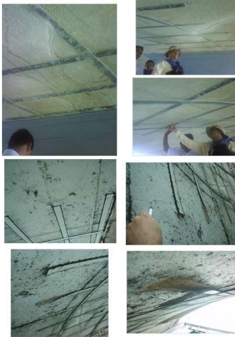
Figura 2.3 Formación de nuevas fisuras en los arcos donde el refuerzo externo tipo CFRP no alcanzaba a cubrir el arco
