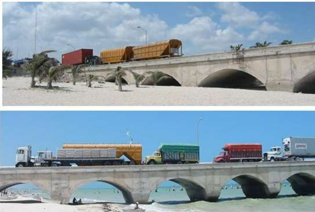
Figura 1.1 Cargas que transitan por el viaducto de arcos durante 2004 y 2005
