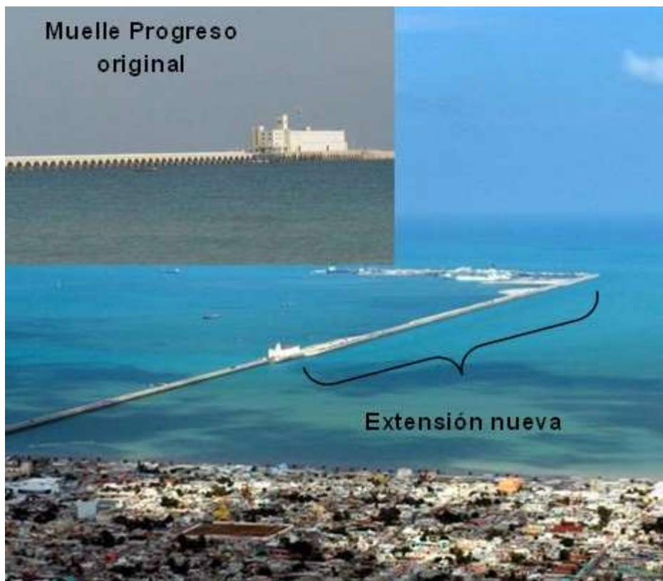
Figura 3.1 Vista aérea del muelle Progreso actual
