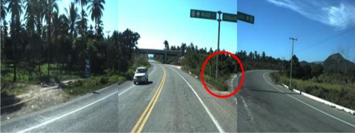
**Figura 4.4: Bifurcación sin dispositivo de amortiguamiento representa un peligro para la vía**
