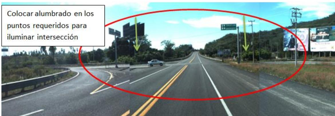
**Figura 5.11: Colocar luminarias en intersecciones**
