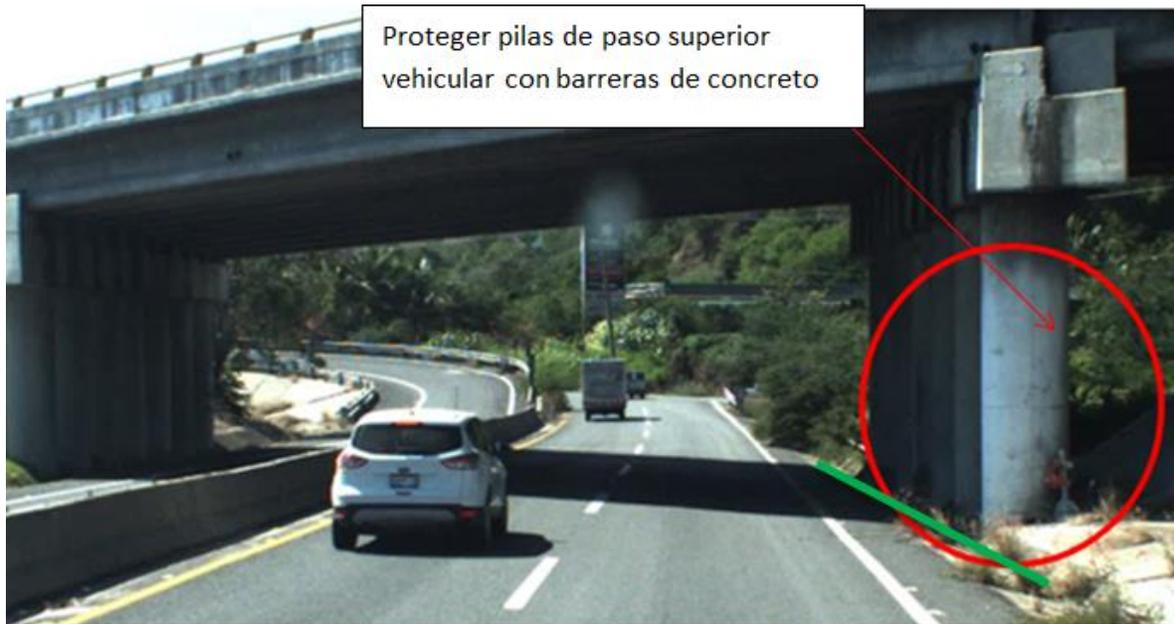
Figura 5.7: Ejemplo de estructura muy cercana a la vía
