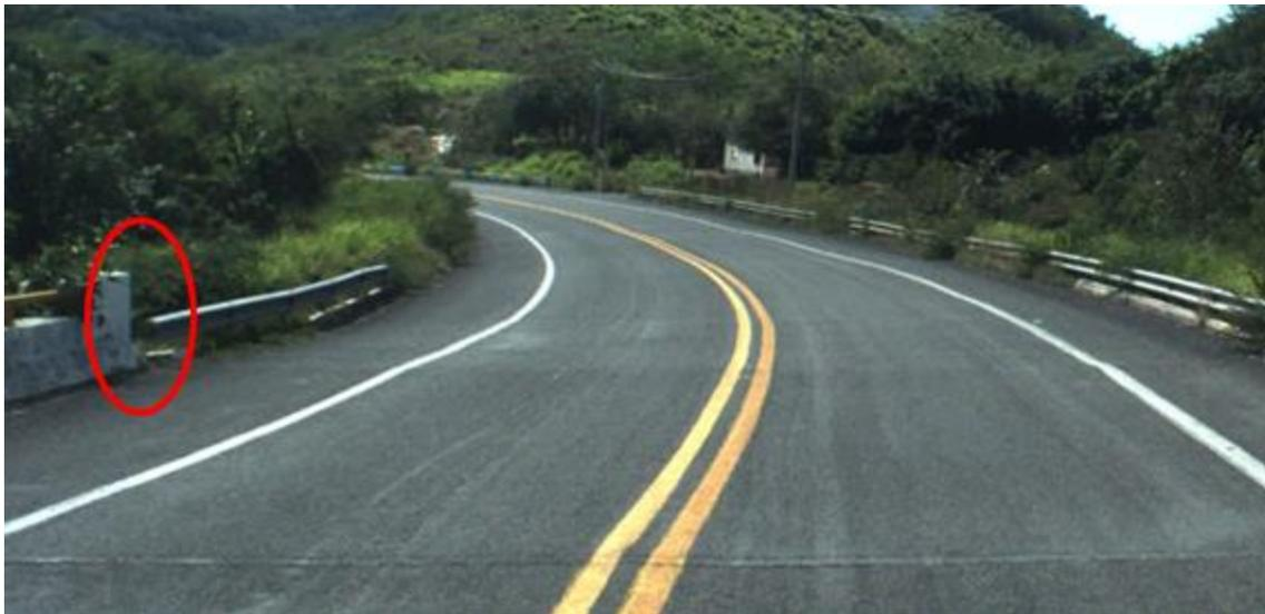
**Figura 4.5: Falta de conexión entre una barrera metálica y el parapeto de un puente**
