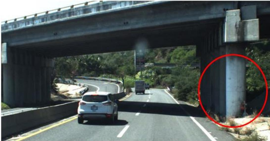
**Figura 4.13: Pilas de paso superior vehicular que representan un peligro para la vía**
