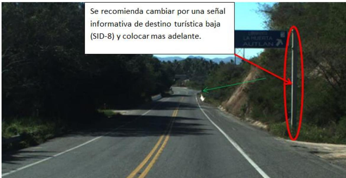
**Figura 5.4: Cambiar señal elevada por señal baja**
