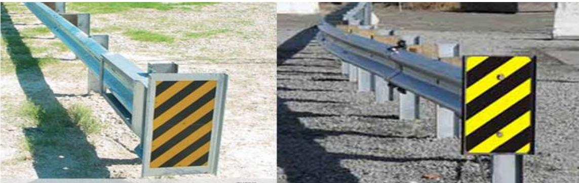
**Figura 5.2: Ejemplos de terminales de impacto para barrera metálica**
