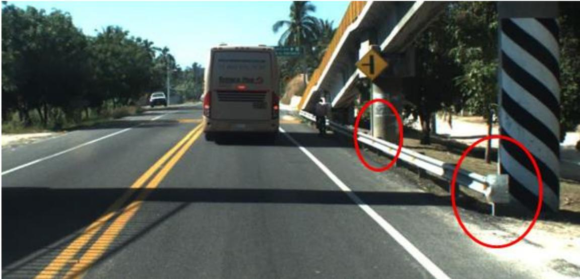
**Figura 4.9: Barrera con ancho de trabajo insuficiente**
