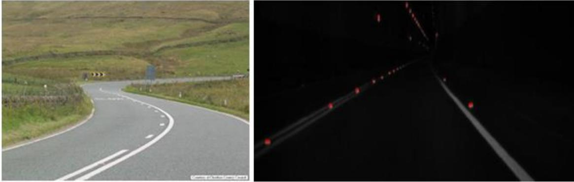
**Figura 3.6: Señalamiento horizontal y vertical**
