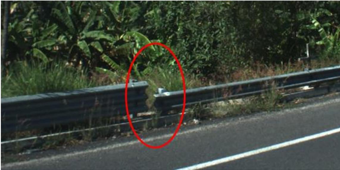
**Figura 4.6: Falta de conexión entre barreras**
