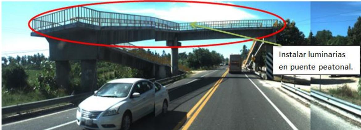
**Figura 5.10: Instalar alumbrado en puente peatonal**
