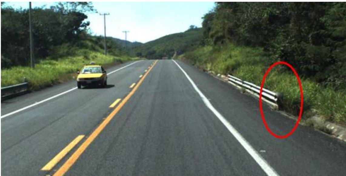
**Figura 4.7: Sección de inicio de barrera sin terminal**
