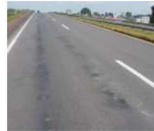
Fotografías del daño a estructuras de pavimento debido a lluvias intensas
