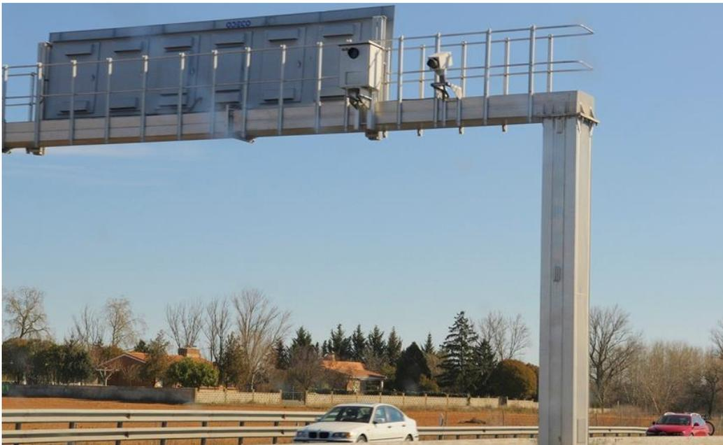
**Figura 5.18 Cámaras montadas en arcos de detección**
