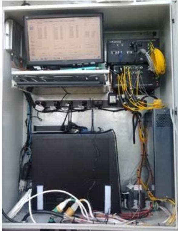
**Figura 2.3 Panel de control del sistema de monitoreo.**
