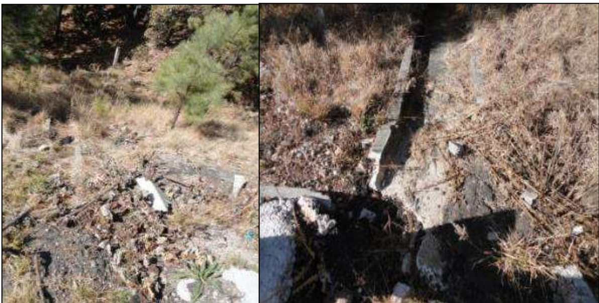
Imagen 5.6 Obras de drenaje del terraplén T1A12
