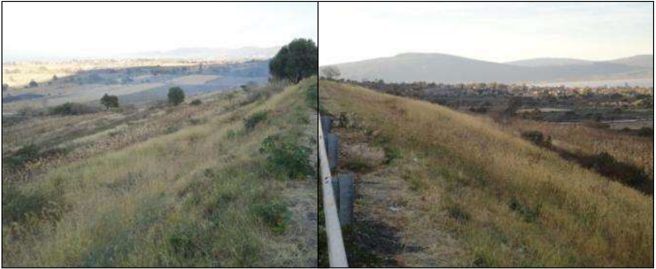
Imagen 5.8 Talud del terraplén T1A18
