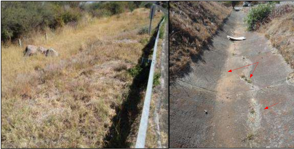
Imagen 5.10 Talud y cuneta central del terraplén T1A22
