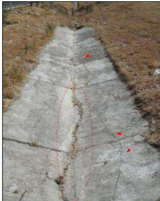
Imagen 5.15 Cuneta central del terraplén T3A39
