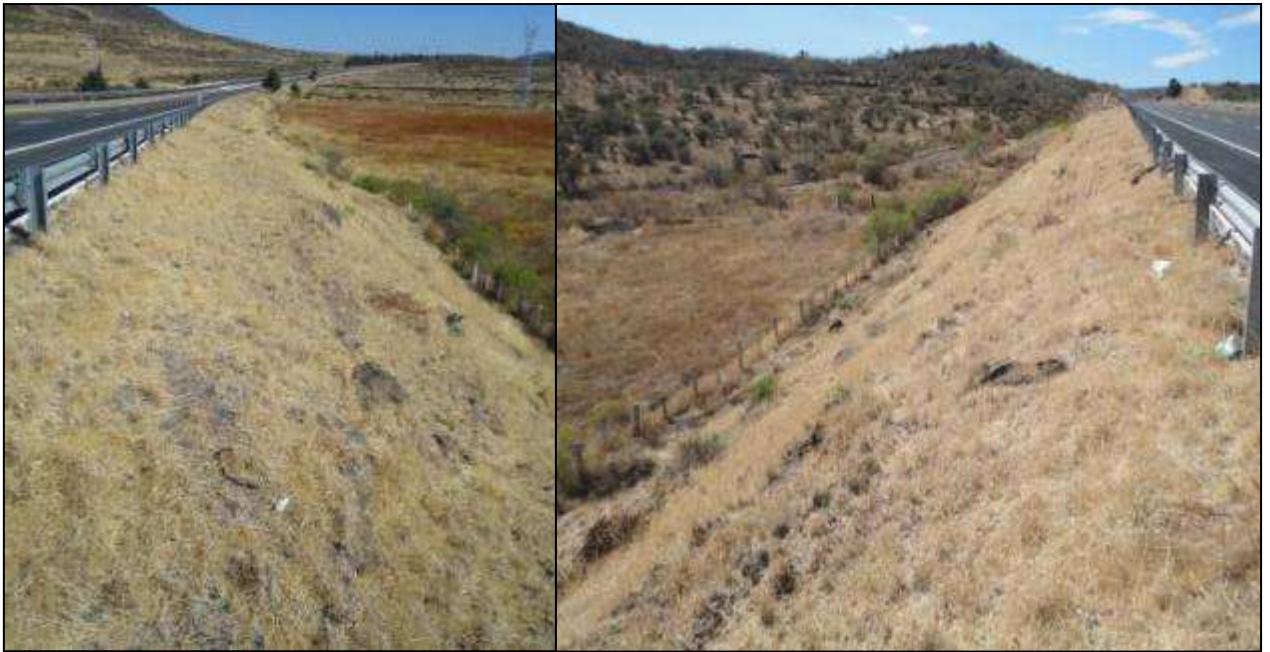
Imagen 5.12 Talud del terraplén T2B30
