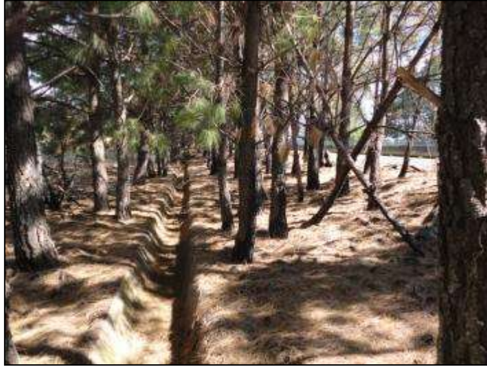
Imagen 5.3 Talud de terraplén T1A09
