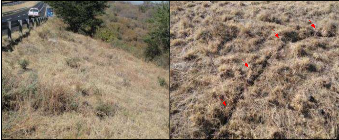
Imagen 5.14 Talud del terraplén T3A39
