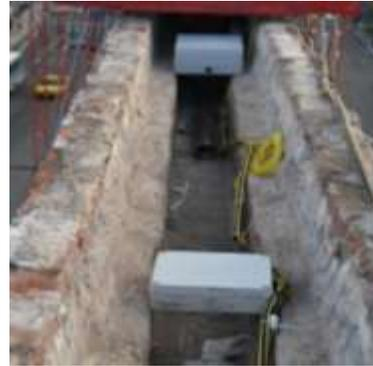
Figura 26. Cajas de empalme sobre el canal
