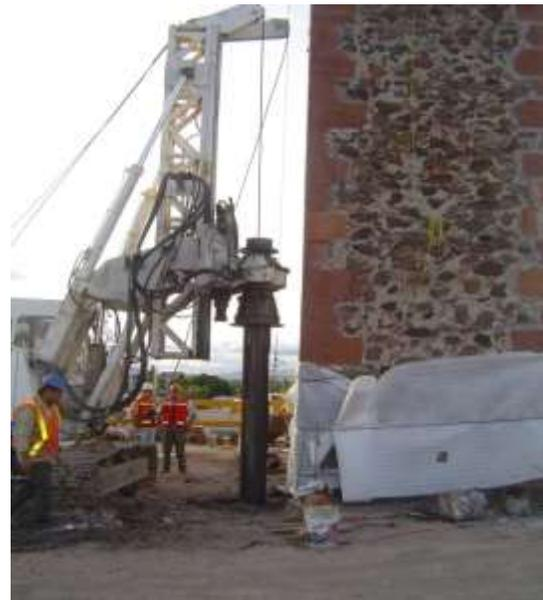
**Figura 43. Perforación en perímetro de pilas para el colado de micropilotes de concreto reforzado colado in situ**
