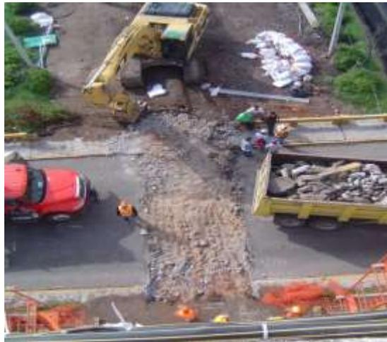
**Figura 42. Excavación de zanja para colocación de ducto de concreto en arco central**
