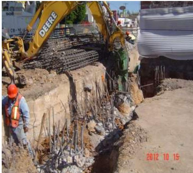
**Figura 44. Colado de micropilotes de concreto reforzado**
