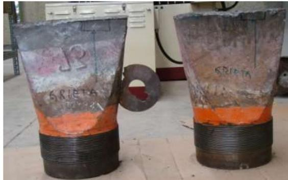
**Figura 15. Elementos de anclaje superior del puente Río Papaloapan**
