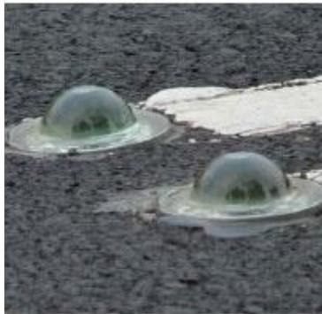
**Figura 4.2** Colocación de la vialeta de vidrio templado sobre pavimento asfáltico.
