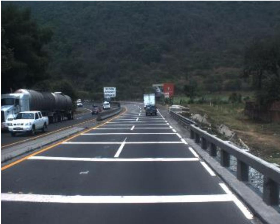
**Figura 2.20 Presencia de barrera central de concreto en un segmento inexistente, en el km. 264+800 y defensa metálica lateral derecha con impactos.**
