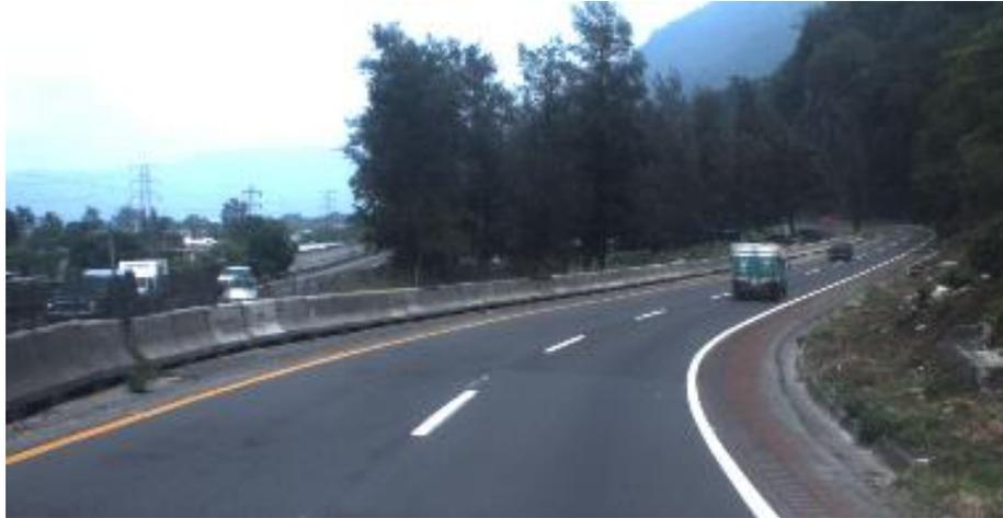
**Figura 2.9** Curva circular inversa en el km. 267+500 y derrumbes al fondo debido al talud pronunciado.
