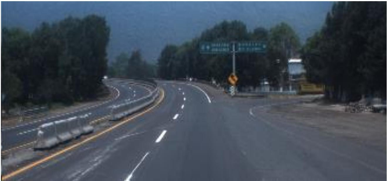
**Figura 3.1 Barrera central de concreto discontinua en el segmento 1.**
