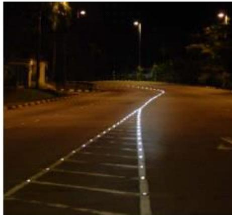
**Figura 4.3** Vista de noche de la vialeta de vidrio templado colocada sobre marcas canalizadoras.
