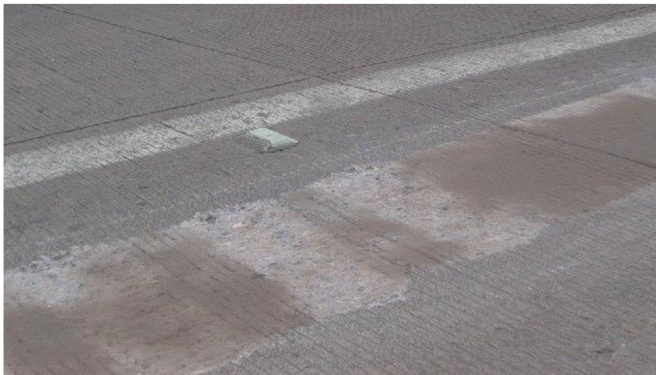
**Figura 4.5 Profundidad adecuada del ranurado del acotamiento para formar tiras de estruendo.**
