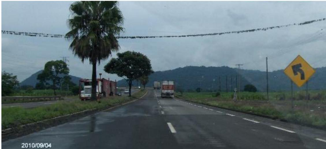
**Figura 2.23 Árboles con troncos gruesos que representan objetos peligrosos para la seguridad vial de los usuarios, en el km 296+000.**
