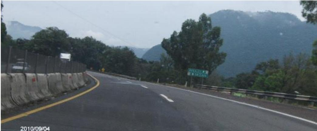
**Figura 2.6 Presencia de barrera de seguridad lateral derecha destruida en el km. 263+000.**
