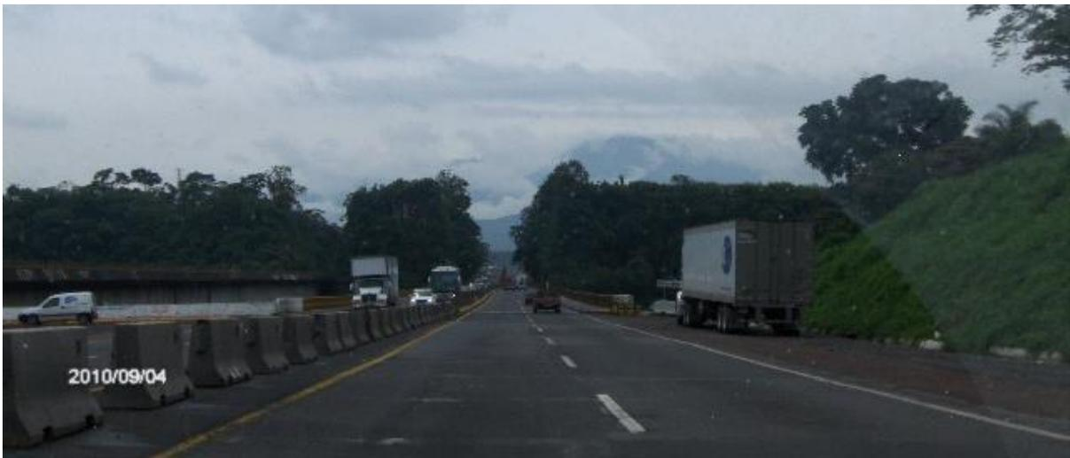
**Figura 2.22 Estacionamiento temporal lateral derecho y barrera de concreto en la faja central sin interconectar, en el km 285+000.**
