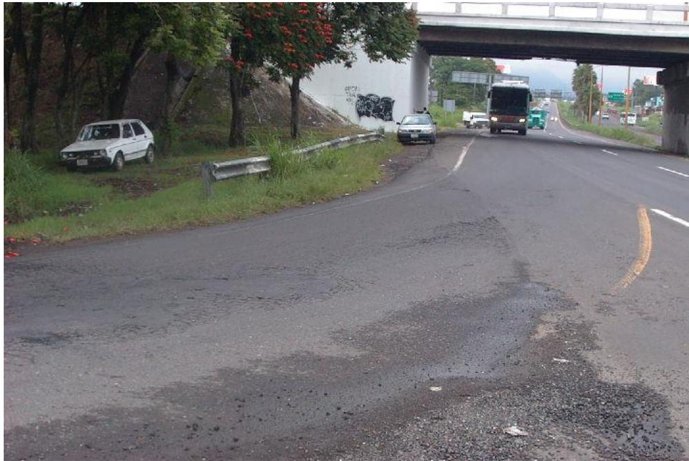
**Figura 3.10 Entrecruzamiento entre los vehículos que toman el ramal de salida hacia Córdoba y los que se incorporan a la autopista por el ramal de entrada.**
