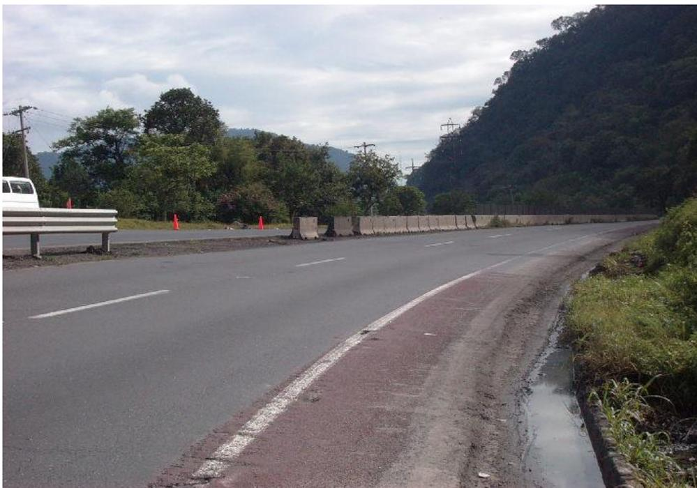
**Figura 3.5 Disposición y discontinuidad de las barreras centrales en el segmento 4.**
