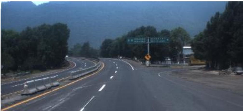
**Figura 2.7 Presencia de barrera de concreto en la faja separadora central muy destruida y en segmentos inexistente en el km. 263+260.**
