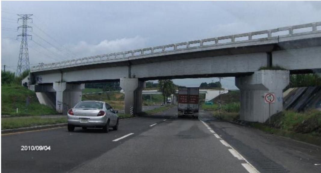
**Figura 2.14 Pilas de puente sin señalización adecuada, en el km 295+800.**
