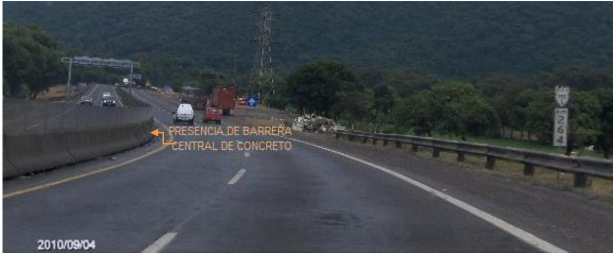
**Figura 2.4 Presencia de barrera de concreto en la faja separadora central en una carretera multicarril real.**
