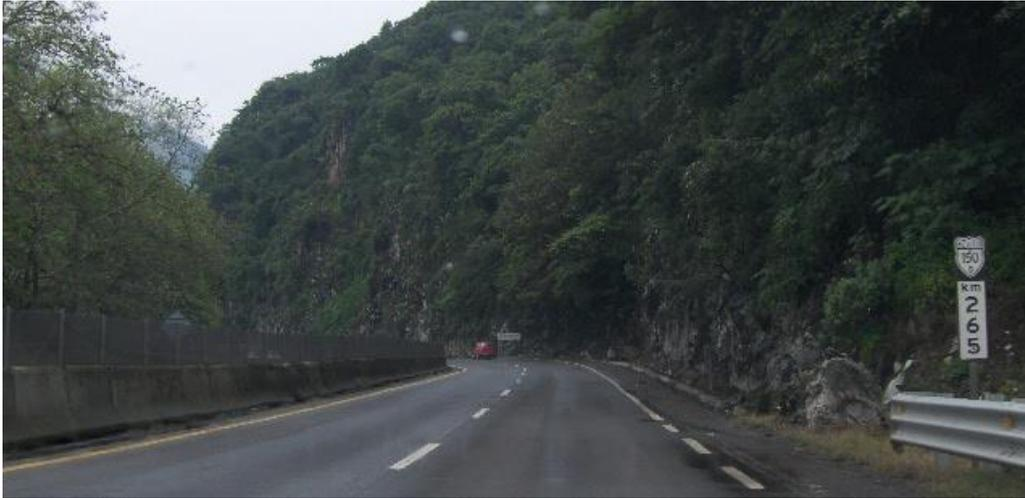
**Figura 2.8 Presencia de impactos en la barrera central de concreto en el km. 265+100 y derrumbes al fondo debido al talud pronunciado.**
