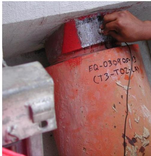
**Figura 2.7 Accesibilidad para la inspección por ultrasonido de un elemento de anclaje superior**
