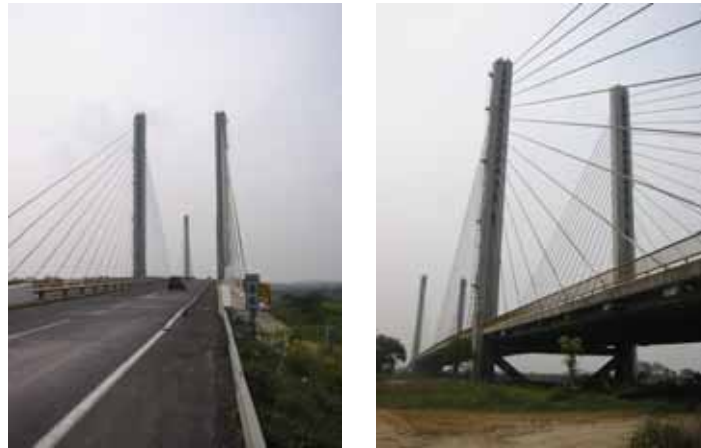
Figura 4.1 Puente Río Papaloapan
