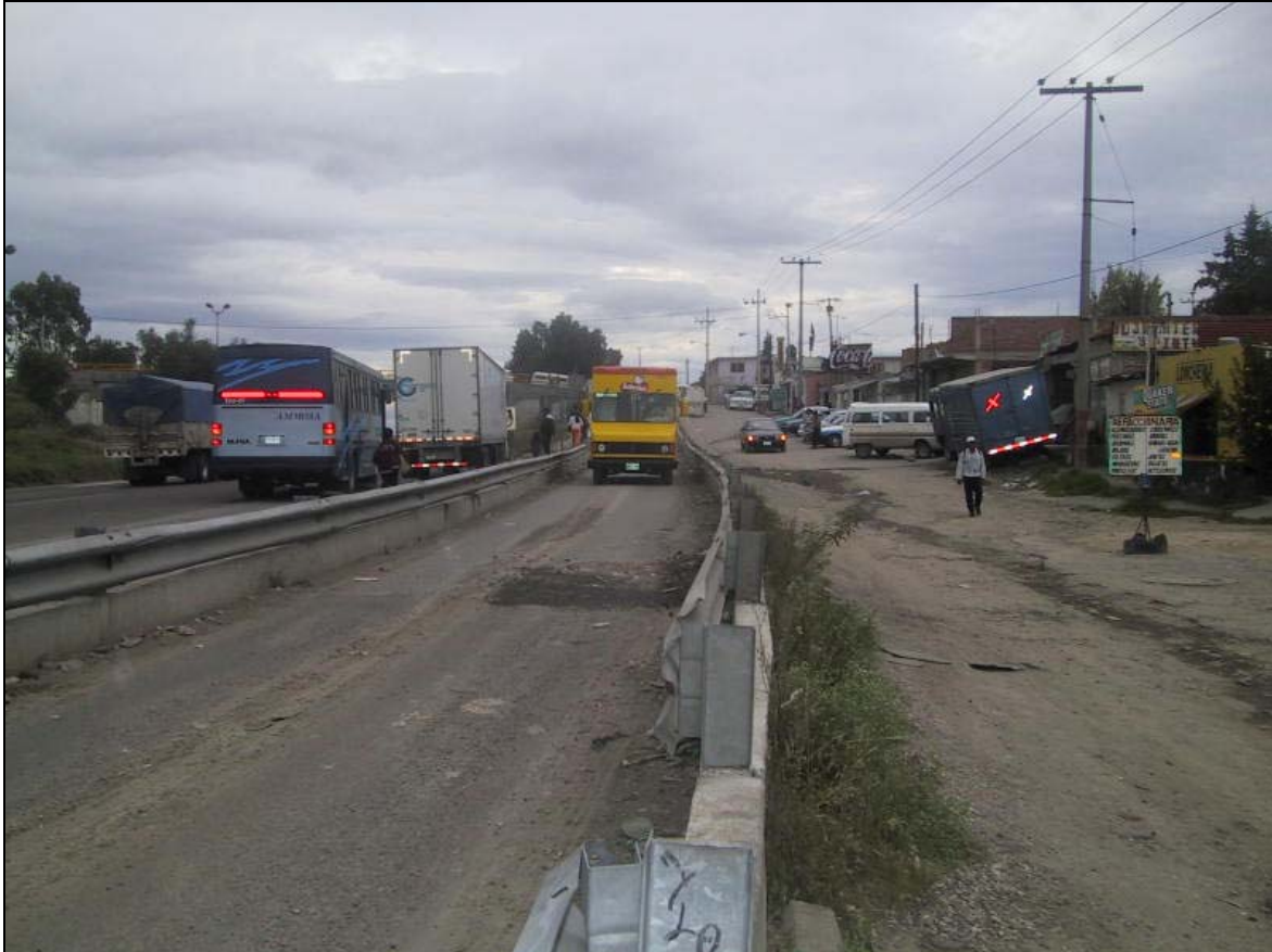
Fotografía 3.2 Vehículo en sentido contrario en una rampa de autopista
