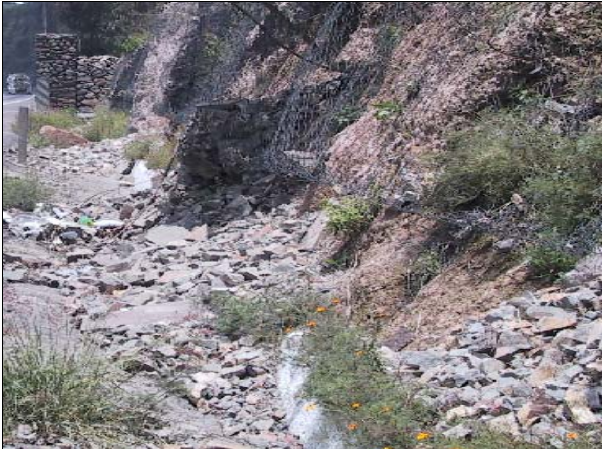
Fotografía 3.3 Azolve de una cuneta por derrumbes
