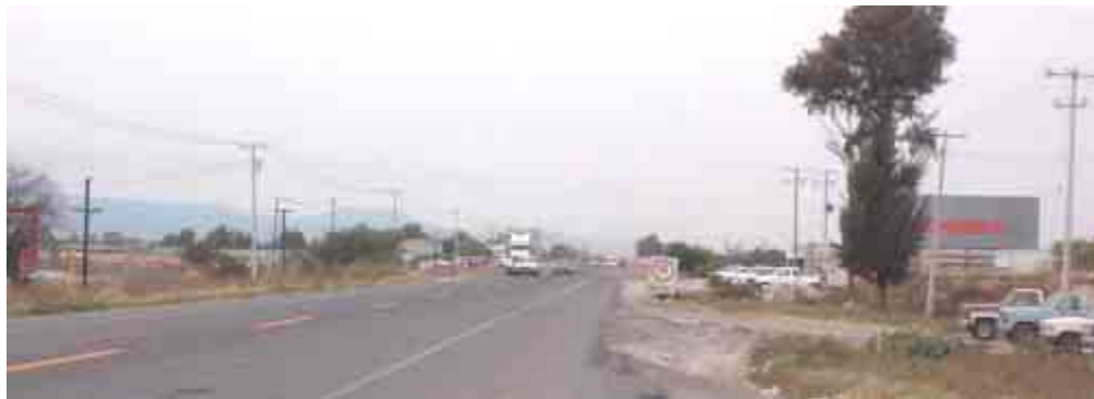
Fotografía 6. Detalles de maniobras de rebase inseguras en la zona central de separación de flujos de circulación, debido a anchos de circulación muy amplios
