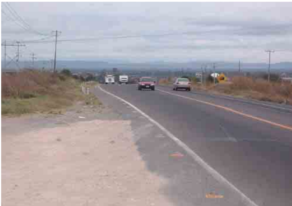
Fotografía 8. Vista del inicio y terminación de un tercer carril de ascenso en una carretera de un carril por sentido
