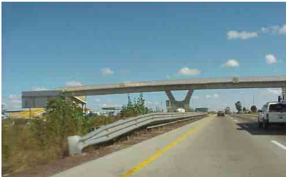
Fotografía 7. Detalles diferentes de estructuras de puentes en el cruce de una autopista, con protección de barrera metálica
