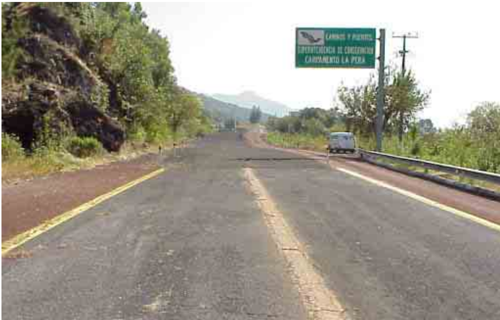
Fotografía 9. Detalles de una rampa de emergencia ubicada en una autopista
