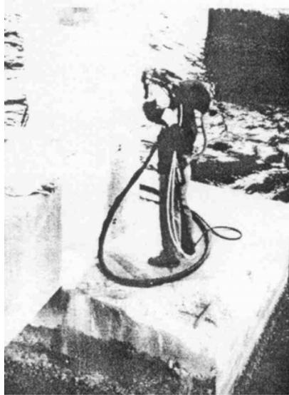
**Figura 2.10 Aplicación de recubierta de zinc en concreto armado (Lasa 2001)**
