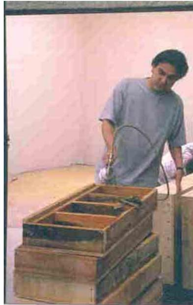
**Figura 3.2 Preparación de los moldes: aplicación de una capa de diesel a los moldes terminados**
