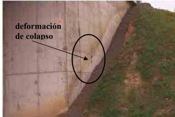
Figura 3.13 Colapso de un terraplén (Alonso, 1998).
