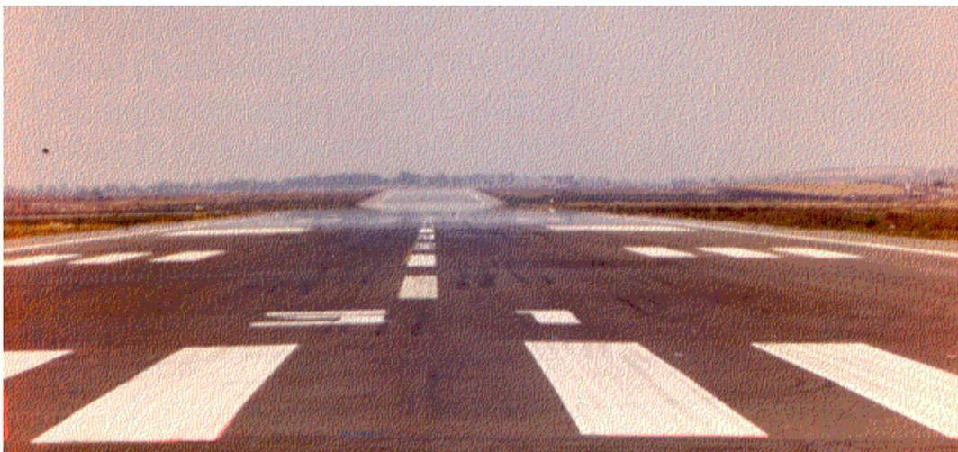
**Figura 5.17** Vistas hacia el SSE y NNW de la pista, su hundimiento.
