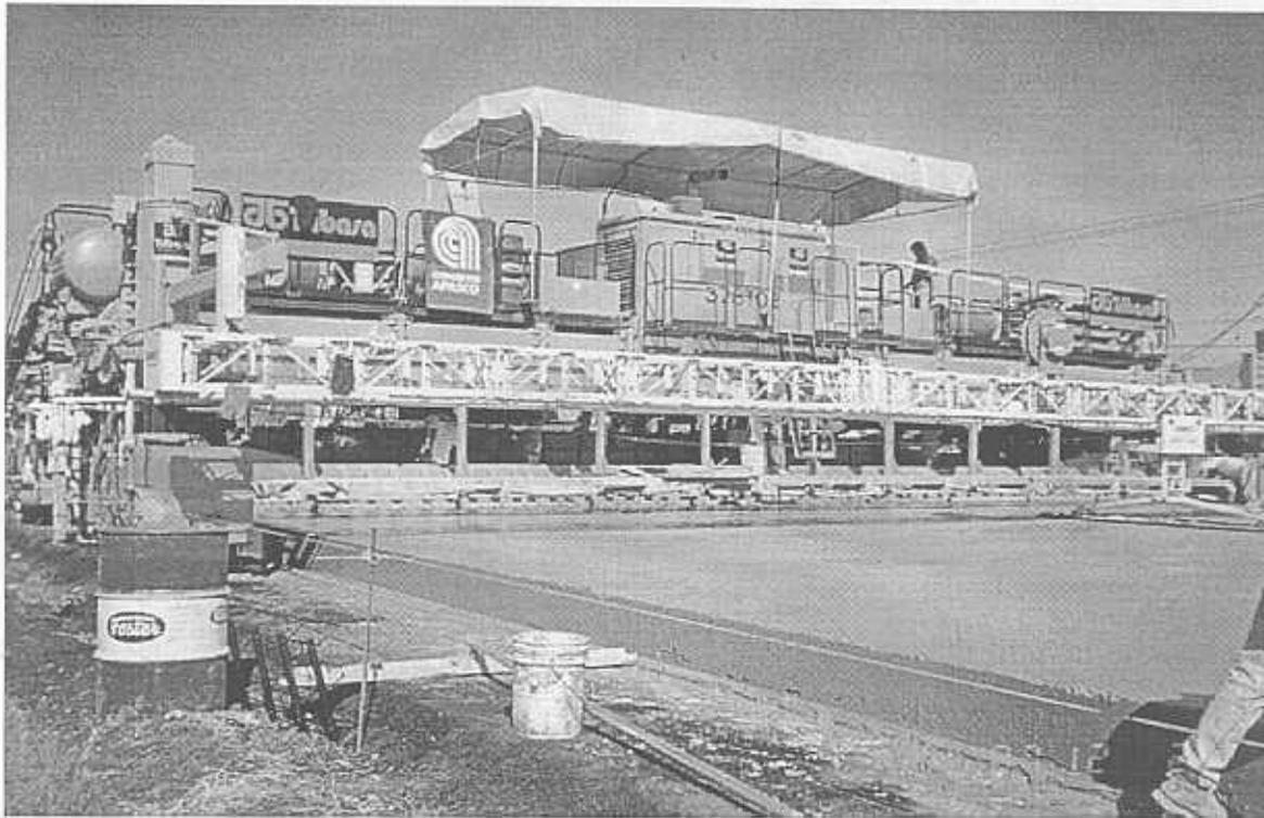
Figura 3. Colocación del concreto hidráulico con máquina extendedora.
