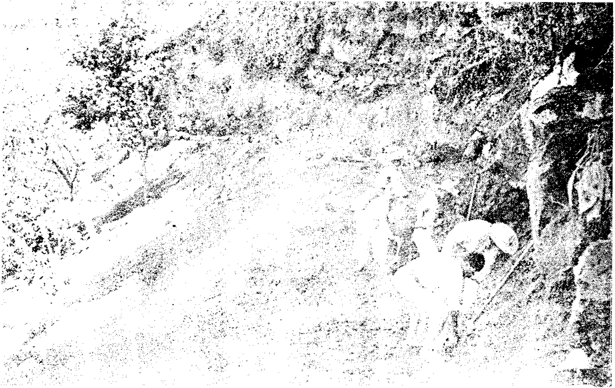
Camino Jalapa-Huatusco-Fortín. Trabajos de construcción en la barranca.
