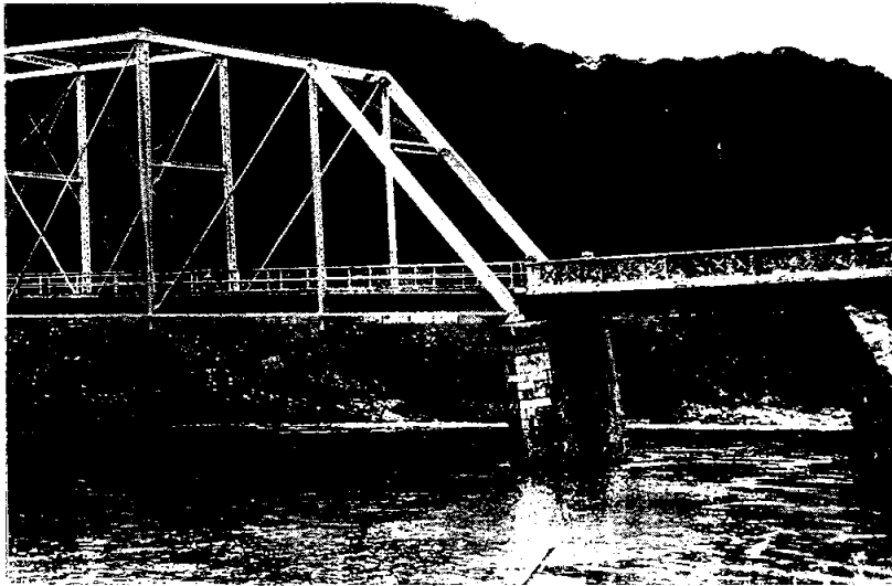
Camino Guadalajara-Barra de Navidad. Puente Armería, estado en que quedó de una creciente del río en 1945. Inclinación de la Pila y Estribo por socavación.
