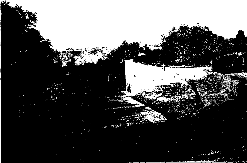
Contratista, Gobierno del Estado, Camino Atotonilco-San Ignacio, tramo Cuesta de Atotonilco, Km. 0+500 atrás, tramo empedrado.
