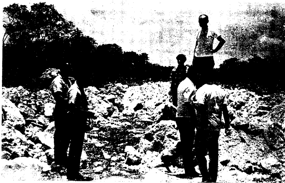
Carretera Transversal de Cozumel en sus inicios (1967). Ing. Santiago Martínez Ríos, Jefe del Departamento de Obras; Ing. Mario R. Heredia Trujillo, Jefe Regional de Laboratorios; Ing. Renán Castro Montes de Oca, de Constructora CUSESA y Javier Martínez Hernández.
