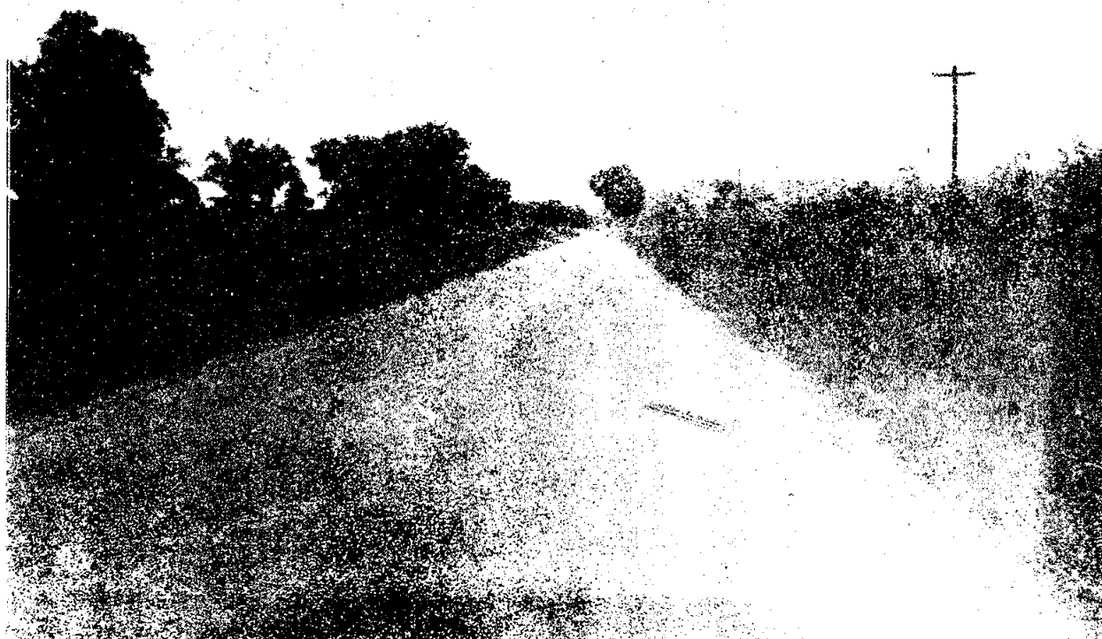
Camino Tihuatlán-Álamo, pavimentación por el sistema de dos riegos, 1956.
