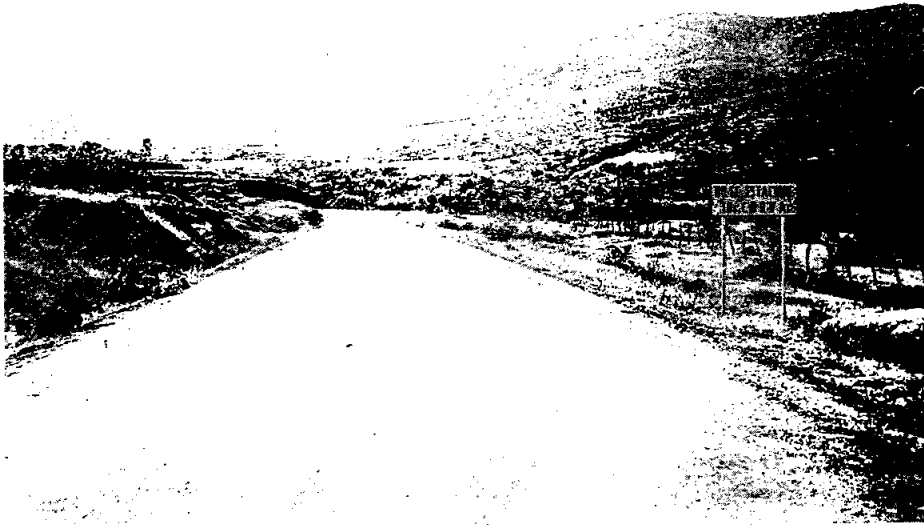
Km. 4+060 adelante, tramo pavimentado.
