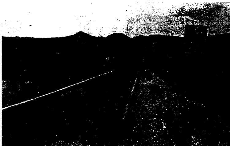
Camino Camargo-Ojinaga, tramo Camargo-La Perla Pavimentado, 1975.
