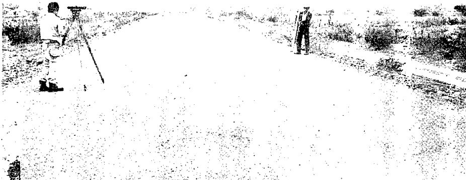
Km. 51+200 adelante, nivelación base terminada.
