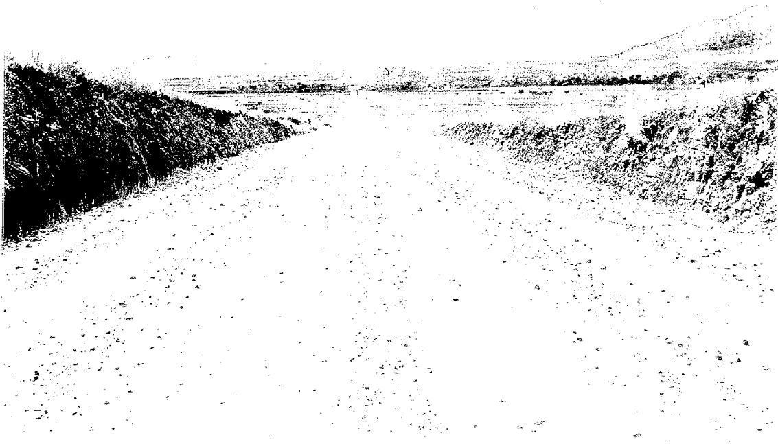
Camino Zacatecas-Moyahua, tramo entronque Escondida-Ruinas de Chimostoc, km.32+000, sentido adelante. 2 de agosto de 1948. Camino revestido, corte en roca, al fondo cruce arroyo Maipaso.
