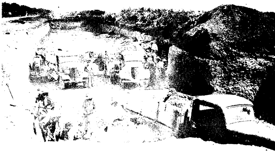
1935. Cargando camiones con material de revestimiento para el Camino Querétaro-Jalpan.
