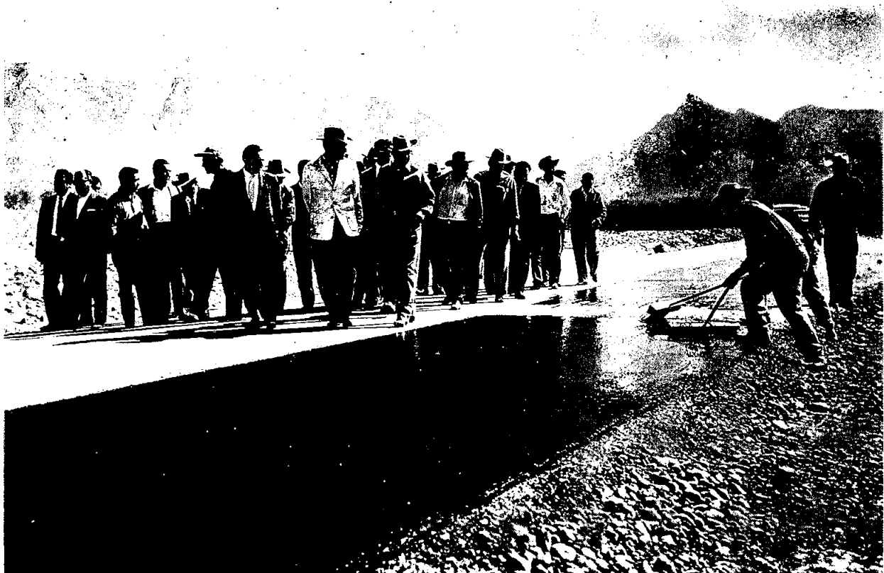
Riego de impregnación de la Carretera: Monterrey-Monclova El Gobernador, Lic. Eduardo Livas y su comitiva, el contratista Arturo García; El Residente de la Junta, Ing. Joel Dewey Saavedra y trabajadores de la JLC.
