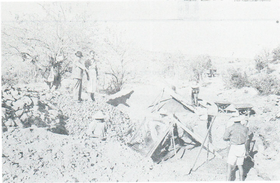
1937. Camino Querétaro-Jalpan. En un banco de aluvión cribando material pétreo.
