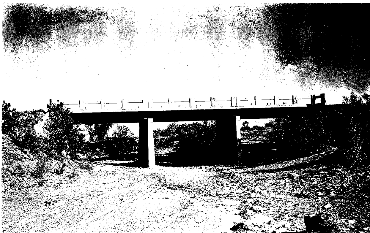
Puente Cieneguilla terminado. Camino Zacatecas-Moyahua, tramo entronque Escondida-Jalpa, Km.3+835, octubre de 1950.
