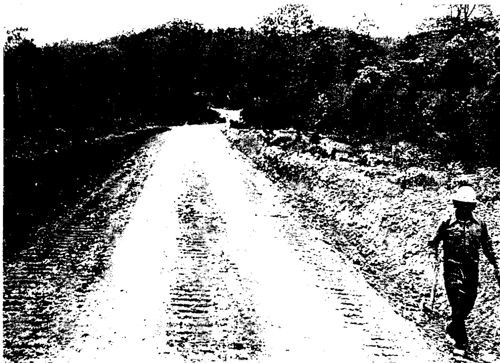
Camino Cajurichi-Uruachi, terracerías terminadas, 1977.
