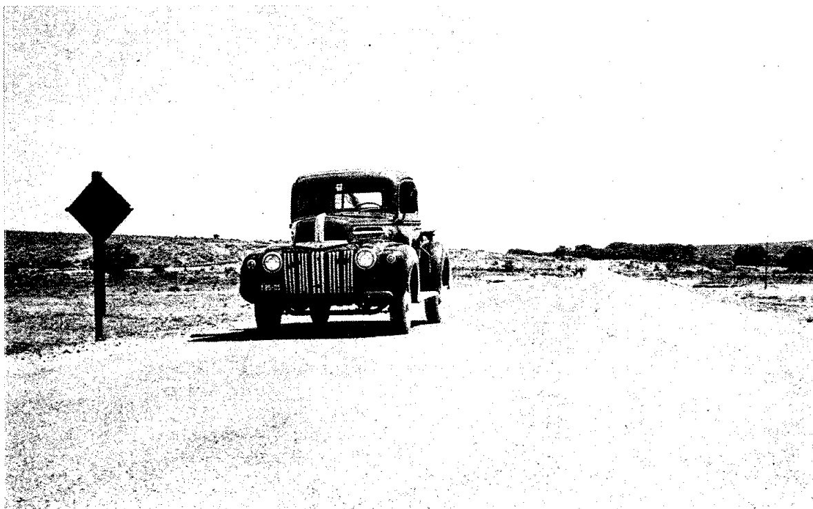
Camino Zacatecas-Moyahua, tramo entronque Escondida-Jalpa, km.17+300, sentido adelante. Etapa de construcción por la Compañía Rivapalacio y Compañía Castanedo. 7 de agosto de 1949. Carpeta con uno y dos riegos, señalamiento de madera.
