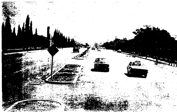
Libramiento Sureste, Cd. Chihuahua, pavimentación terminada, 1974.
