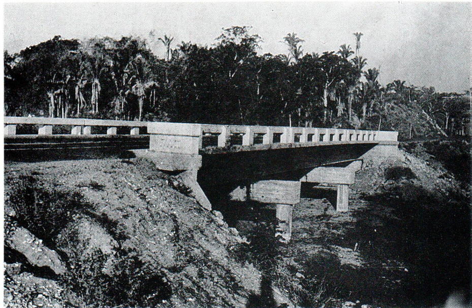
Camino Guadalajara-Barra de Navidad. Puente Jaluco Auxiliar.
