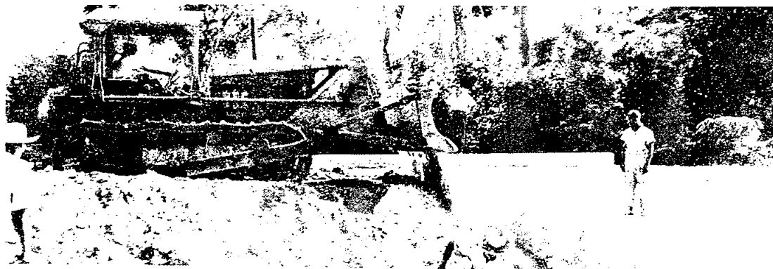
Una vez terminada la alcantarilla, se rellenan los accesos para ponerla en uso. Hasta el más modesto camino vecinal requiere de estas indispensables obras de drenaje.
