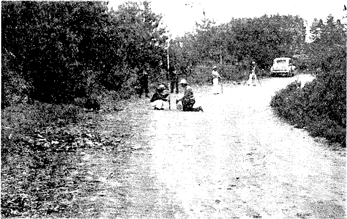
Camino Perote-Altontonga-Jalacingo. Modificando curva en Km.17+000.
