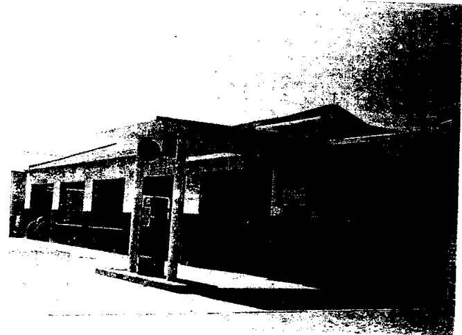
Gasolinera, fosas para lavado y engrasado.
