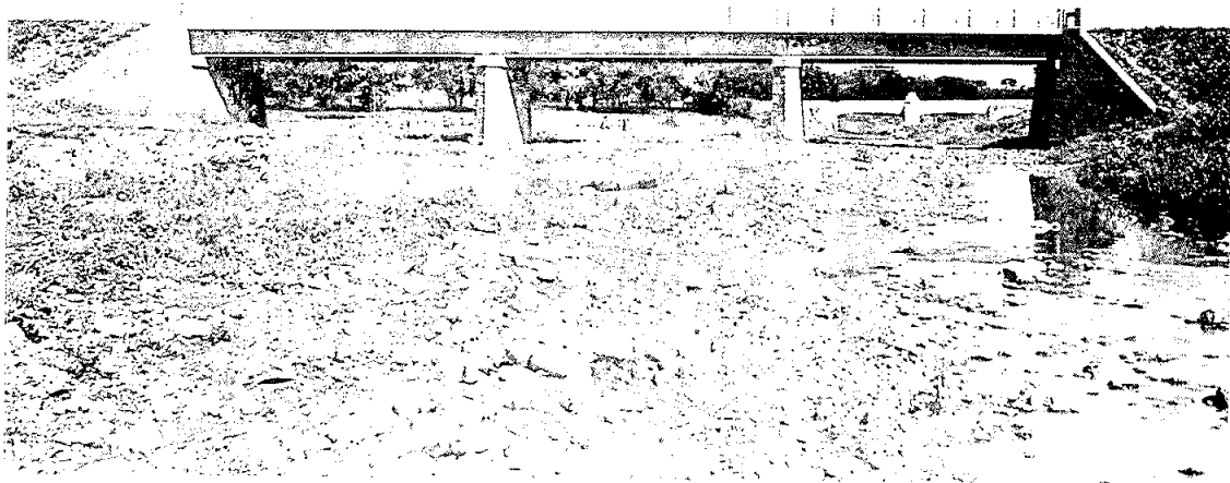
Camino Zacatecas-Moyahua, tramo entronque Escondida-Villanueva, km.49+980, sentido aguas abajo. Etapa de construcción 7 de diciembre de 1948. Puente Coyotes terminado.
