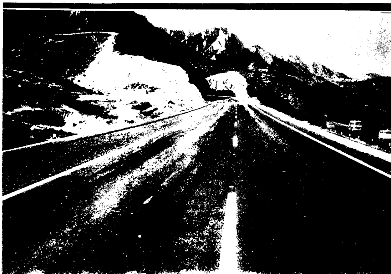
Camino: Saltillo-Monterrey Tramo: Santa Catarina - Lim. Edos. Nuevo León y Coahuila. Tramo terminado 100% con raya central y lateral. Vista del Km. 47 al Km. 46. Programa estatal de construcción.
