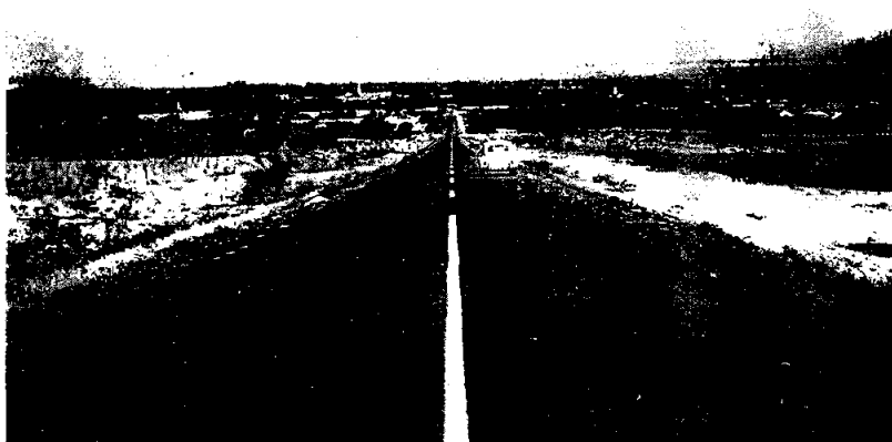
Camino Sayula-Venustiano Carranza, tramo Apango-Venustiano Carranza. Contratista, Construcciones Desmontes y Promociones, S.A., Km. 1+900 tramo pavimentado.
