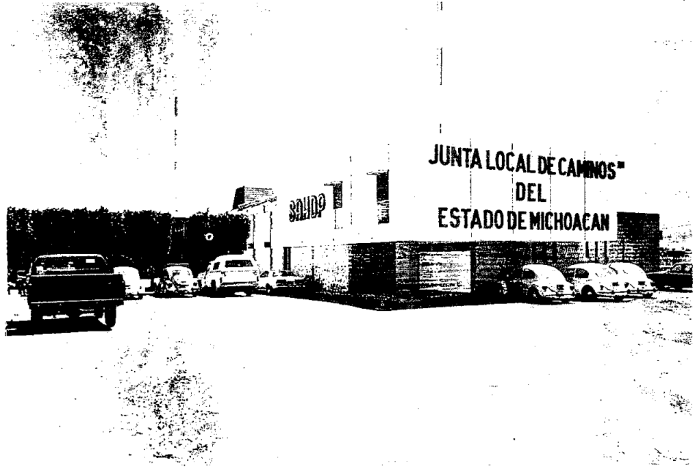
Fachada principal del edificio de la JLC.
