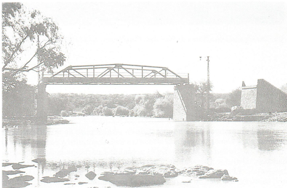
Camino Zapotlanejo-La Piedad. Km. 158+900. Puente de El Salto sobre el Río Lerma, falta losa en claro auxiliar y terraplén de acceso.
