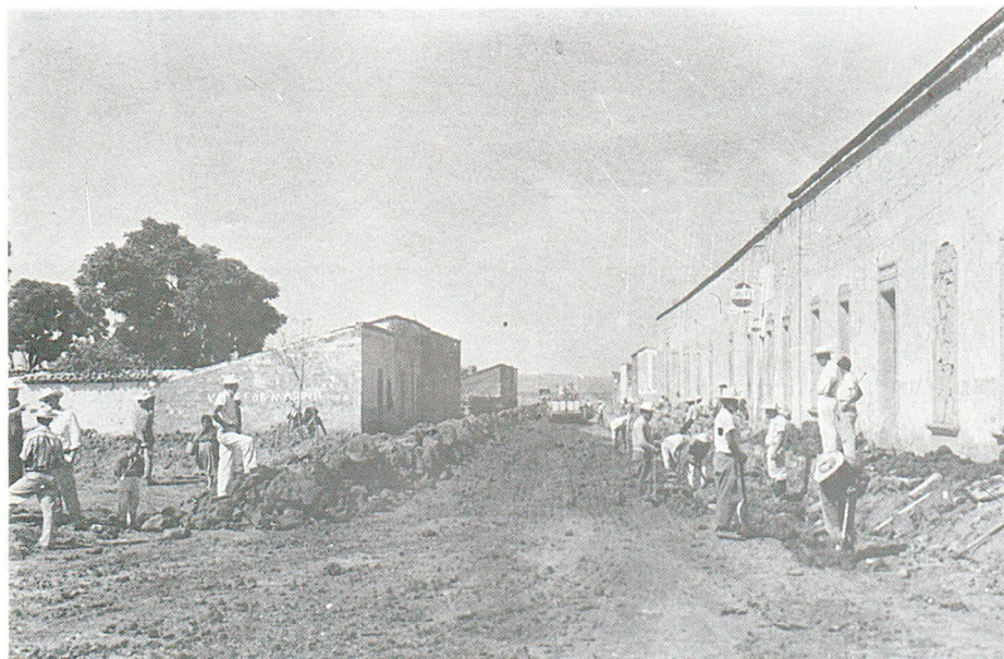
Camino Zapotlanejo-La Piedad. Paso Degollado, Km. 149+800, arreglando calle Degollado y triturando revestimiento para sub-base.
