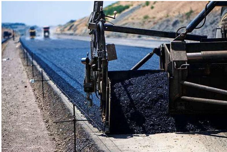
**Figura 1.3 Mezclas asfálticas para la construcción de carpetas utilizadas en pavimentos flexibles.**
