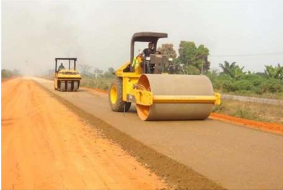
**Figura 5.1 La compactación es un factor importante en la caracterización mecánica de los materiales granulares.**
