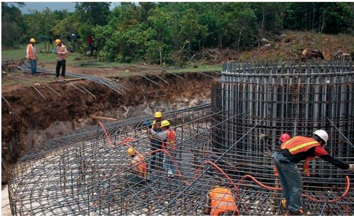
Figura 1. Ejemplo de cimentaciones superficiales en puentes.
