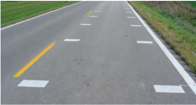
Figura 3. Marcas provisionales en el pavimento
