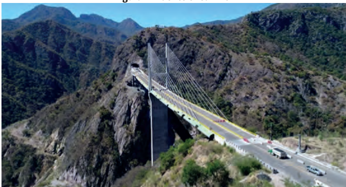
Figura 1 - Puente el Carrizo
