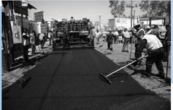
Figura 4 Reciclado de carpetas en carreteras
