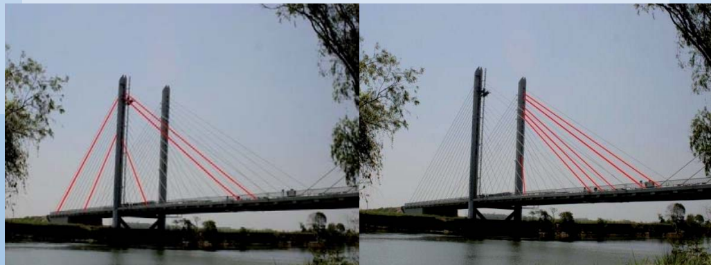
Torre 3 Arpas 1 y 2
