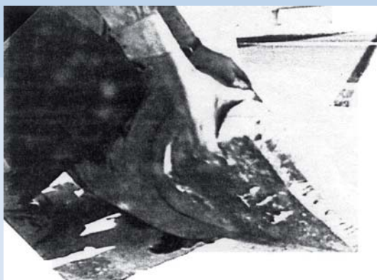
Figura 2 Imágenes de la falla del tirante 11, semi-arpa 7 en el año 2000
