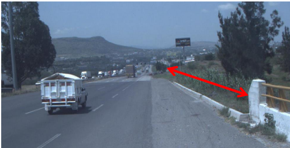
Figura 4.17 Instalación y conexión de barrera metálica al parapeto del puente, sitio 2
