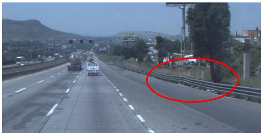
Figura 4.12 Sistema de contención impactado, sitio 2
