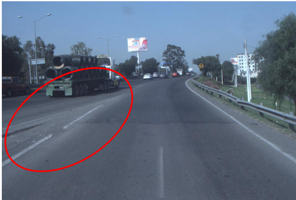
Figura 4.20 Falta de rayas canalizadoras, sitio 1
