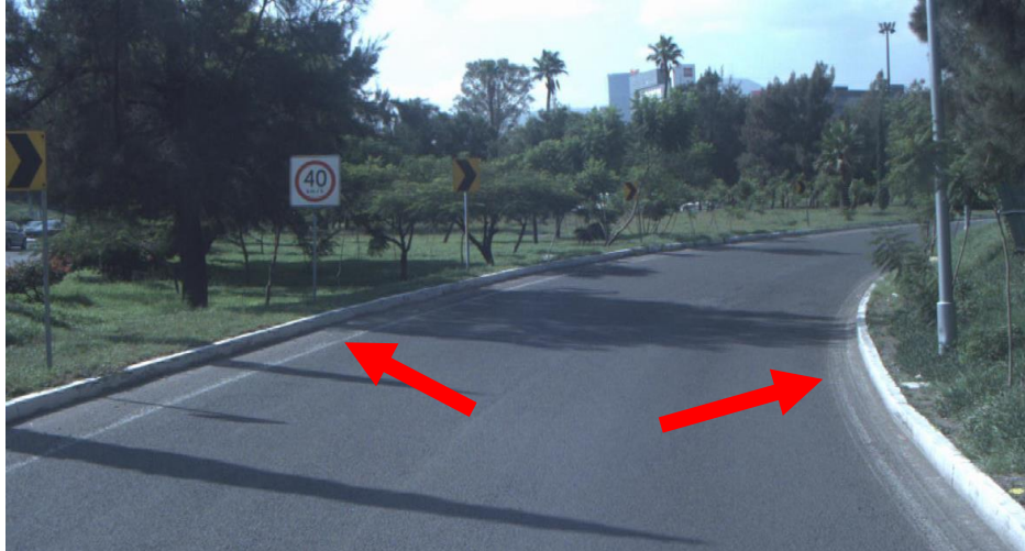
Figura 4.23 Falta de conservación de las rayas del señalamiento horizontal, sitio 1
