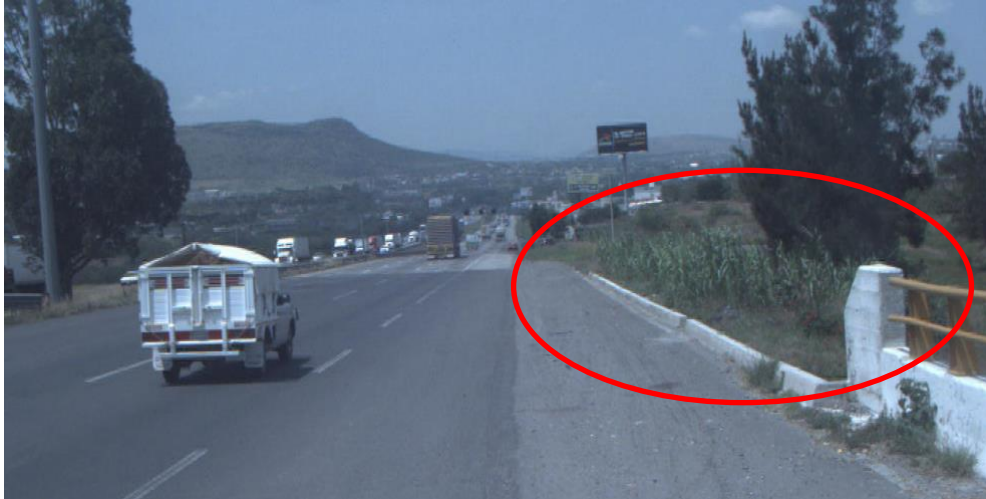
Figura 4.16 Terminación de una barrera de concreto en parapeto de puente, sin continuidad de barrera lateral metálica, sitio 2
