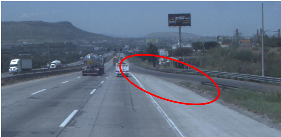
Figura 4.22 Falta de conservación de las rayas canalizadoras, sitio 2
