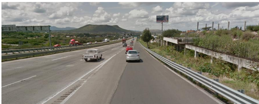
Figura 4.5 Operación actual del carril de aceleración en el sitio 2
