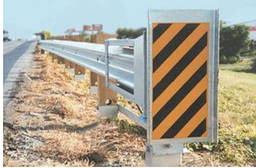
Figura 4.10 Ejemplo de sección de amortiguamiento para barreras metálicas
