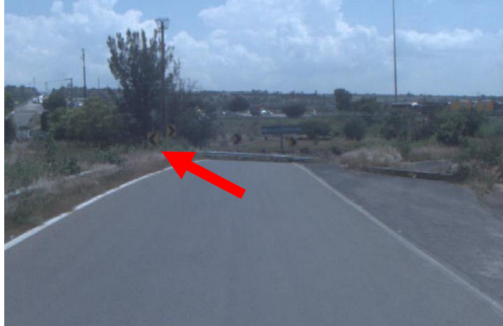
Figura 4.24 Falta de conservación y mantenimiento del señalamiento vertical, sitio 2
