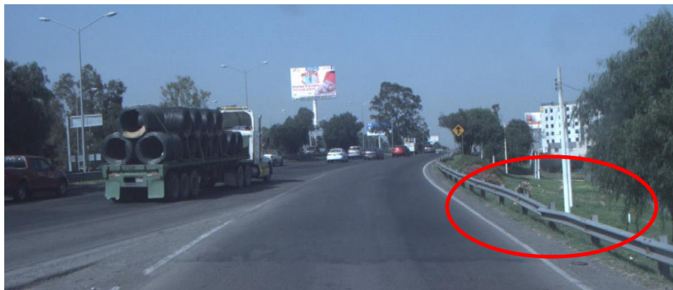
Figura 4.11 Sistema de contención impactado, sitio 1
