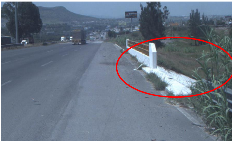
Figura 4.14 Transición inadecuada entre sistemas de contención, sitio 2
