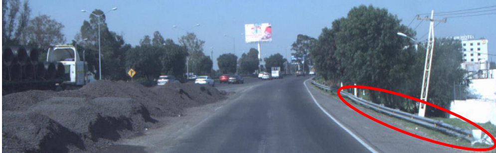
Figura 4.19 Altura inconsistente del sistema de contención, sitio 1
