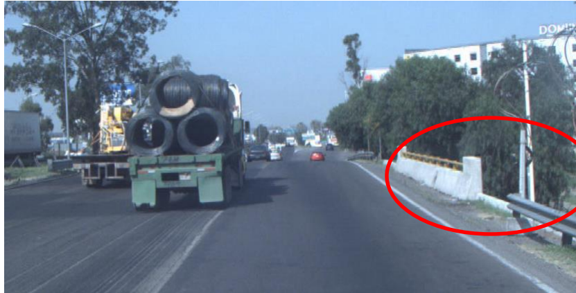
Figura 4.13 Transición inadecuada entre sistemas de contención, sitio 1
