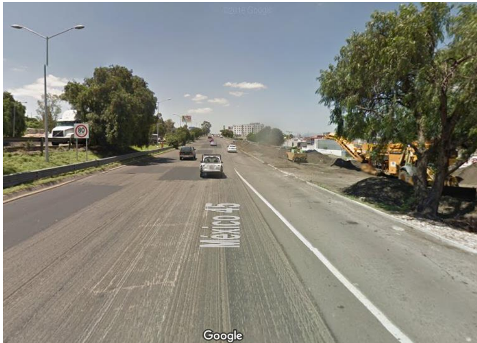
Figura 3.7 Carretera MEX-057, km 208+000 al 208+500, incorporación del Boulevard Bernardo Quintana
