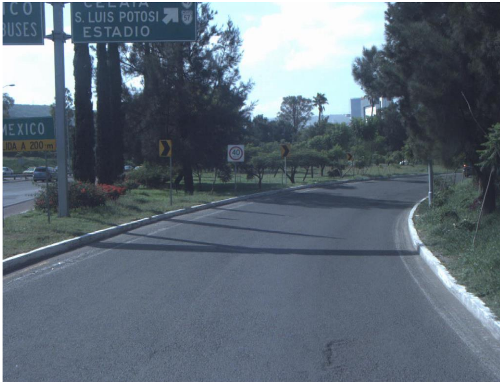
Figura 3.5 Gaza de incorporación del Boulevard Bernardo Quintana a la carretera MEX-057
