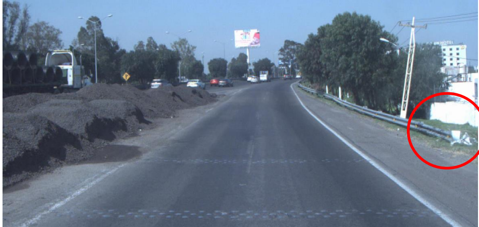
Figura 4.8 Inicio de barrera sin protección, sitio 1
