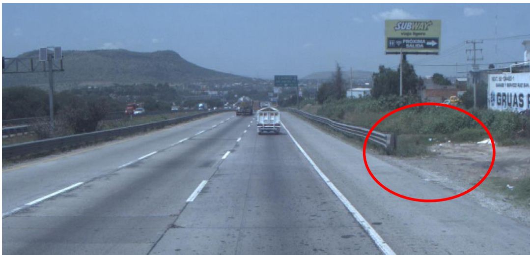
Figura 4.9 Inicio de barrera sin protección y acceso irregular, sitio 2
