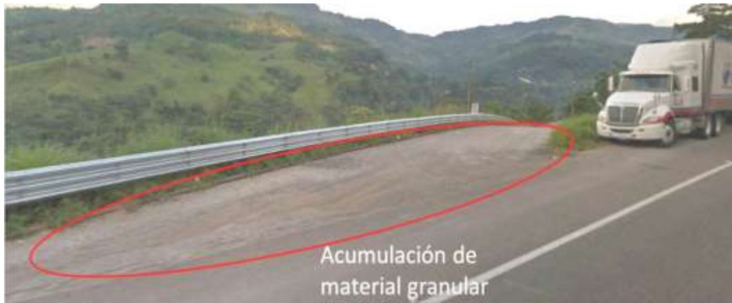
Figura 2.29 Acumulación de material granular en la incorporación a la carretera del entronque 2
