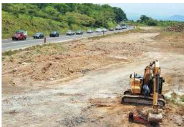
Figura 1.13 Movimiento de tierras para la ampliación de la carretera La Pera-Cuautla, publicado en nota periodística por Excélsior
