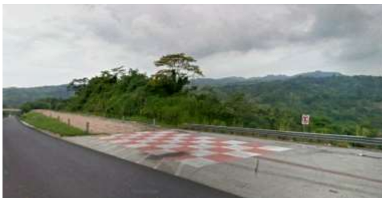
Figura 2.18 Rampa de frenado ubicada en el km 160+300
