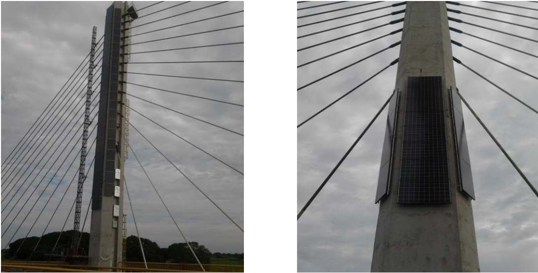
Figura 4.3 Paneles solares en puente Río Papaloapan.
