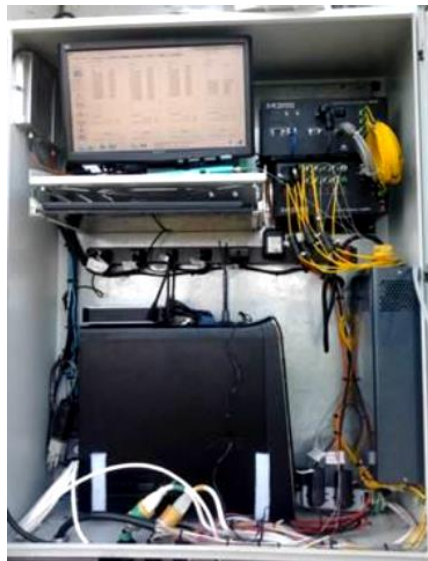
Figura 4.5. Gabinete de control del puente Río Papaloapan.
