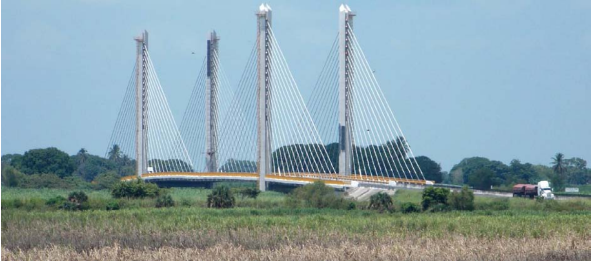
Figura 4.1. Puente Río Papaloapan.
