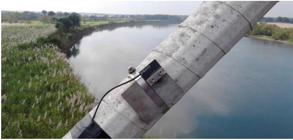
Figura 2.1 Acelerómetro instalado en tirante del puente Río Papaloapan.
