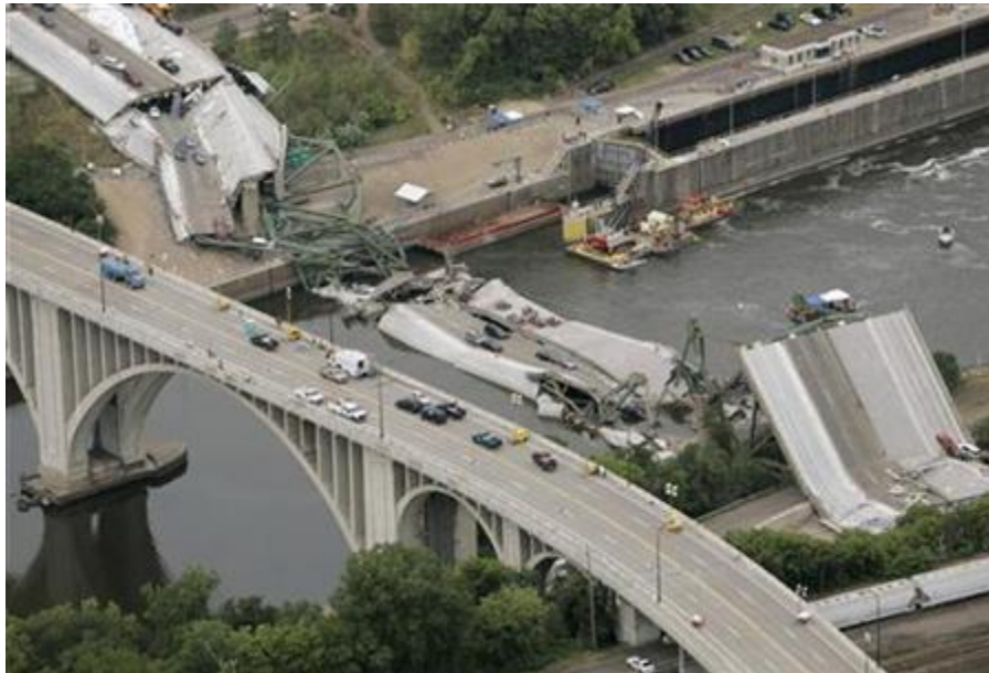
Figura 1.1 Colapso de puente vial I-35W en Minneapolis, USA.
