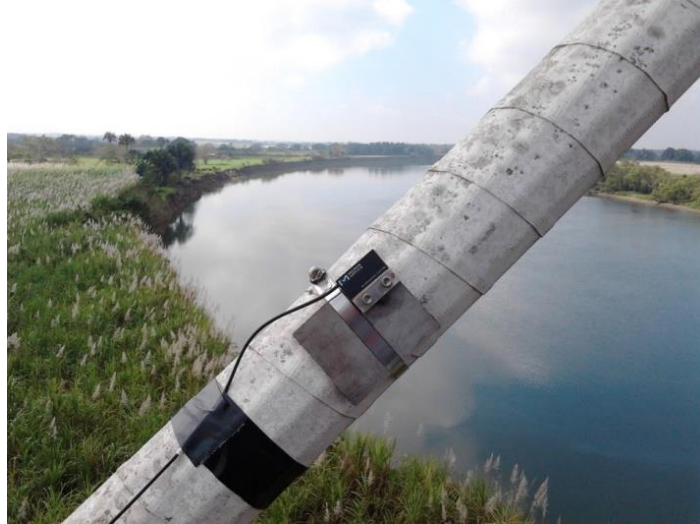
Figura 4.4 Acelerómetro instalado sobre tirante del puente Río Papaloapan.
