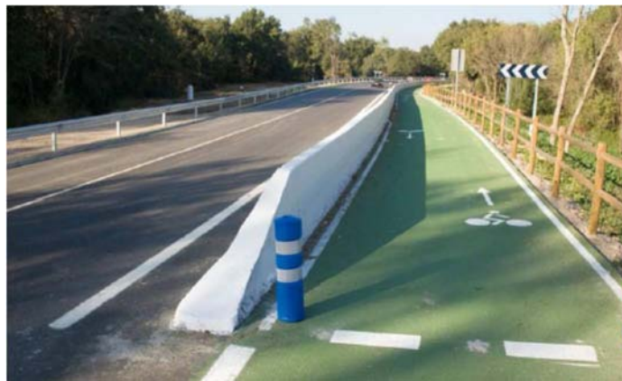
Figura 4.14 Ejemplo de una vía protegida para el tránsito exclusivo de bicicletas en una carretera
