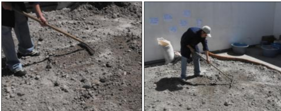
Figura 3.2. Extendido y secado del material pétreo.
