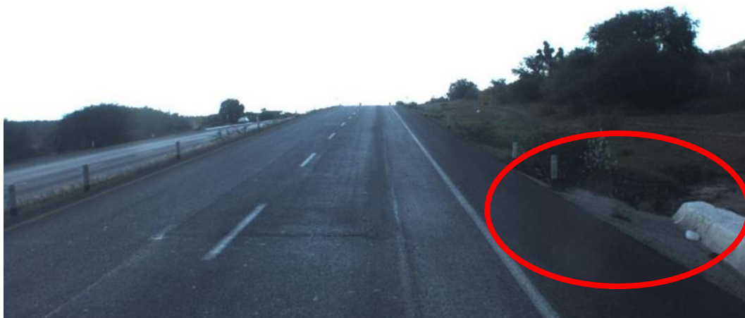
Figura 4.8 Boquilla de drenaje que representa un peligro
