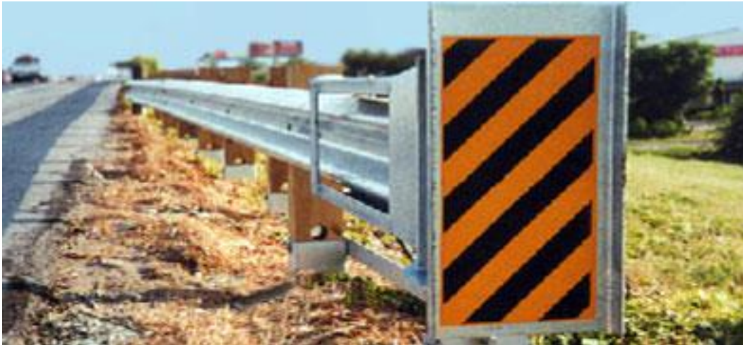
Figura 5.7 Ejemplo de terminal de impacto para barreras metálicas centrales o a la orilla del camino
