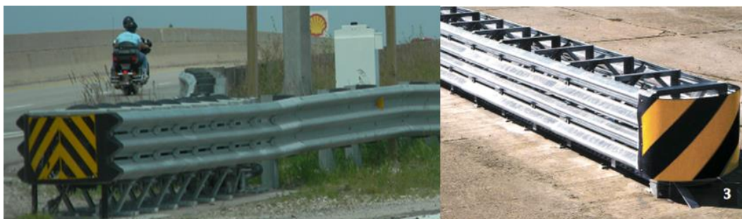
Figura 5.6 Ejemplos de amortiguadores de absorción de impacto
