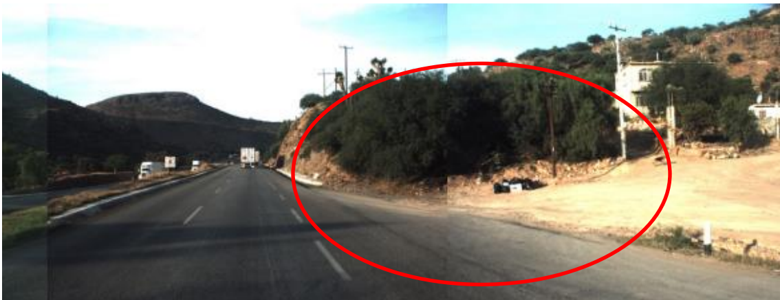
Figura 4.39 Acceso irregular sin carriles auxiliares
