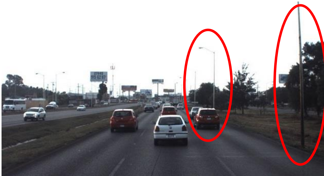
Figura 4.4 Poste de luminaria que representa un peligro en la vía
