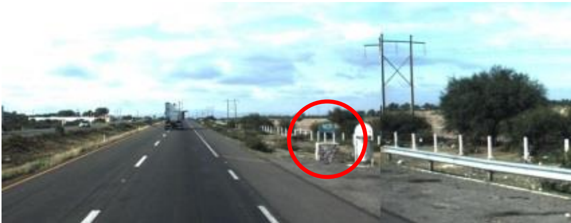
Figura 4.6 Tanque de mampostería mal ubicado que afecta la seguridad de la vía
