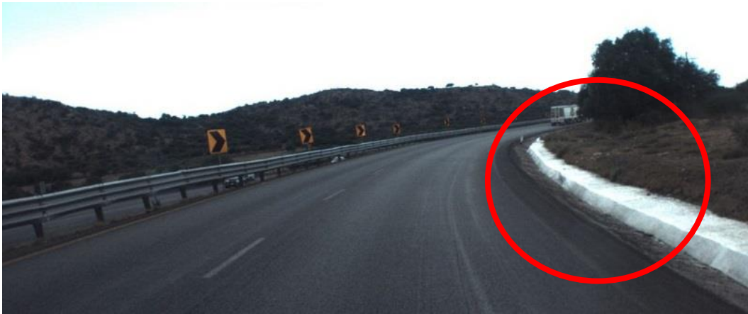
Figura 4.9 Presencia de cuneta profunda en el tramo carretero
