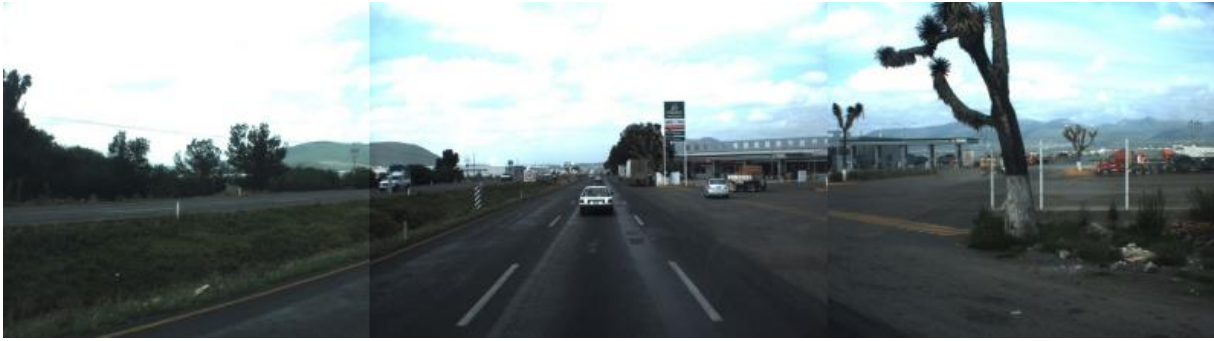
Figura 4.22 Las incorporaciones y salidas de la vía principal son ubicaciones incorrectas para la colocación de bandas alertadoras
