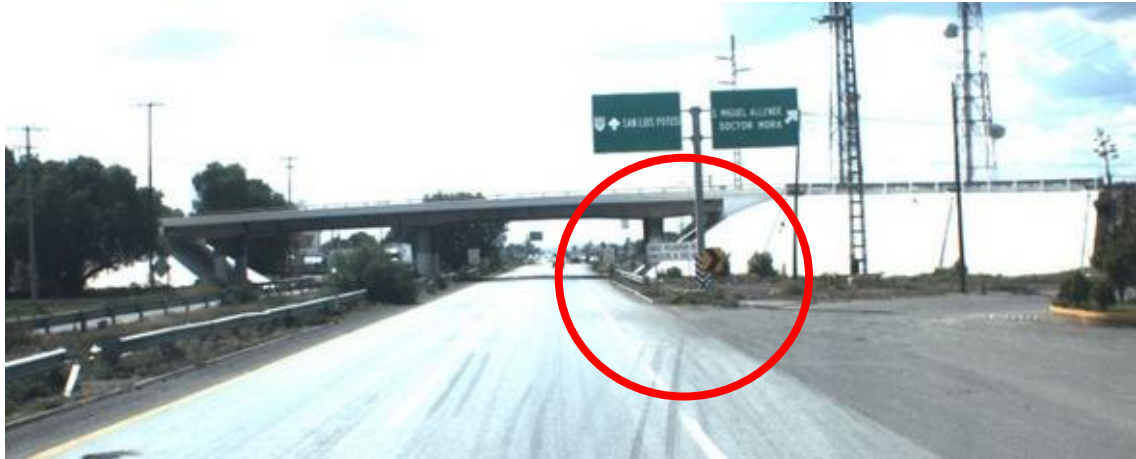
Figura 4.10 Bifurcación de la vía con falta de dispositivo de amortiguamiento
