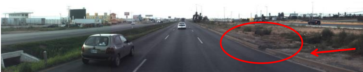
Figura 4.25 Acotamiento externo inexistente y bordillo ubicado muy cerca del arroyo vehicular
