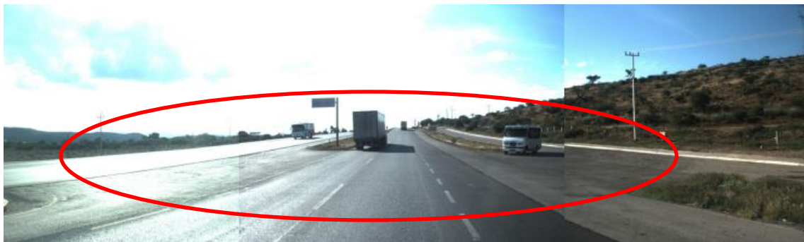
Figura 4.47 Intersección peligrosa a nivel en el km 160+280
