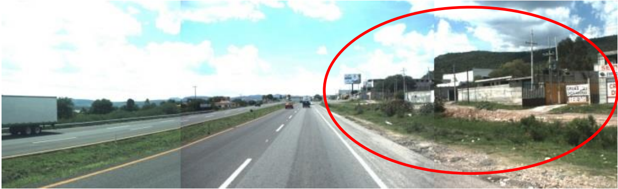
Figura 4.26 Falta de iluminación en tramo carretero
