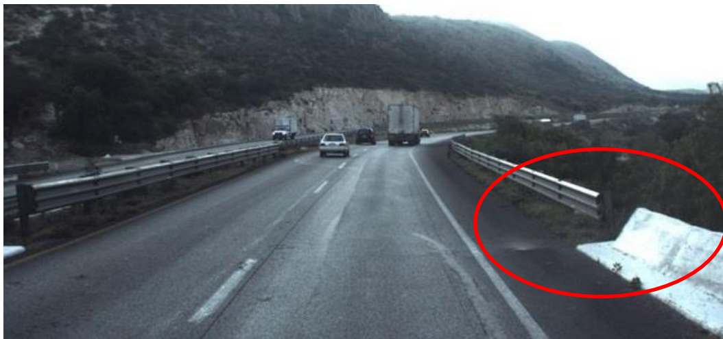
Figura 4.11 Falta de transición y conexión entre la barrera metálica y el parapeto de concreto del puente vehicular
