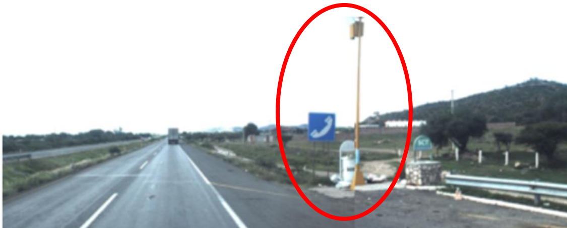
Figura 4.3 Poste SOS que representa un peligro en la vía
