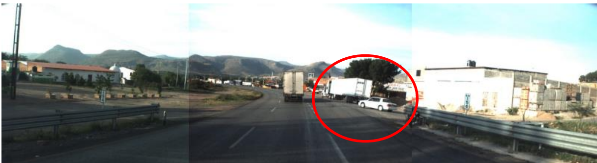
Figura 4.16 Ausencia de señal de incorporación del tránsito SP-17
