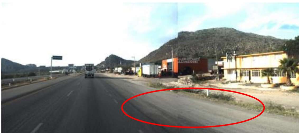
Figura 4.35 Mal estado de la superficie del pavimento en carriles auxiliares
