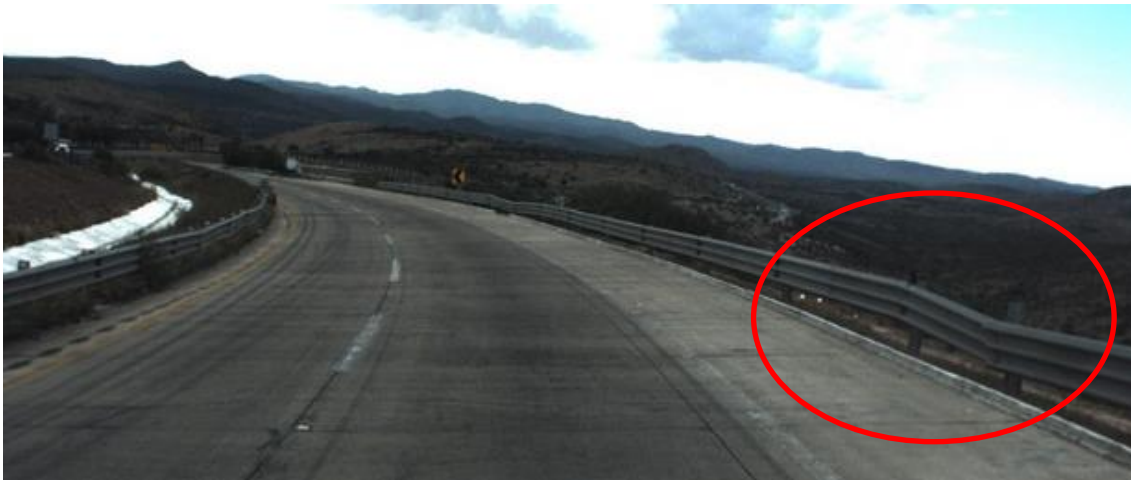
Figura 4.13 Presencia de barrera metálica impactada
