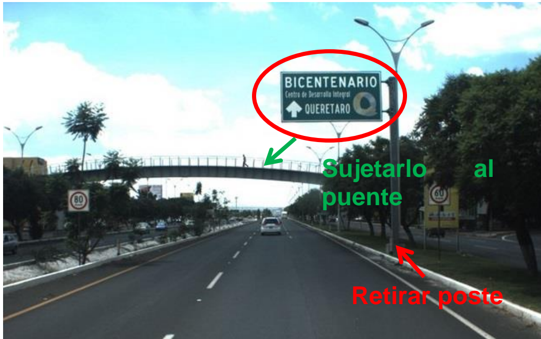
Figura 5.1 Medida de mejoramiento propuesta que consiste en retirar el poste y sujetar el tablero al puente peatonal
