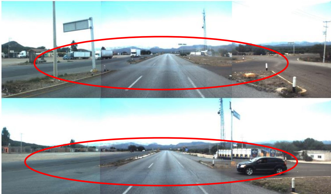
Figura 4.46 Intersección peligrosa a nivel en el km 140+060
