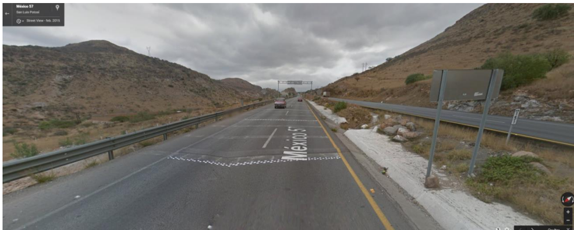
Figura 5.18 Ejemplo de rayas logarítmicas en el km 151+000 de la Carretera Querétaro-San Luis Potosí
