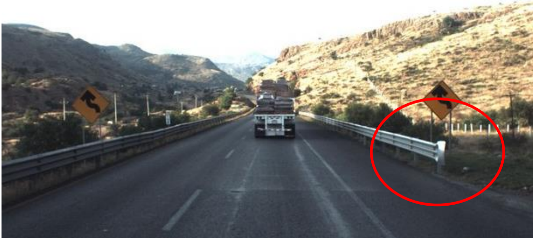
Figura 4.12 Presencia de barrera metálica con terminación peligrosa
