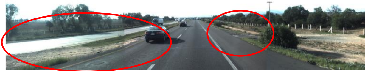
Figura 4.43 Retorno irregular en la faja separadora central y acceso irregular en lado derecho de la vía
