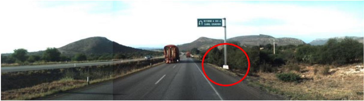
Figura 4.17 Ausencia de señal indicadora de obstáculo OD-5 en el poste de señal bandera SID-13 de “Retorno”
