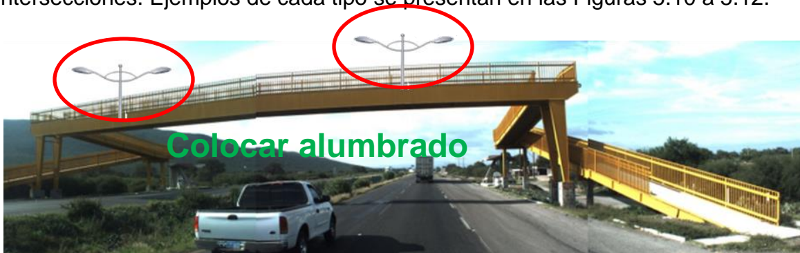
Figura 5.10 Mejorar la visibilidad en los cruces peatonales mediante la colocación de alumbrado
