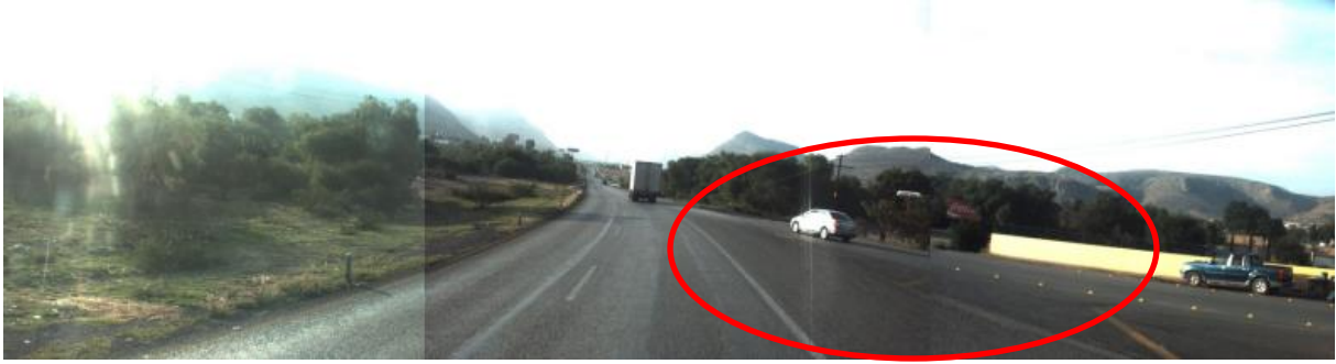
Figura 4.20 Falta de conservación de las marcas horizontales
