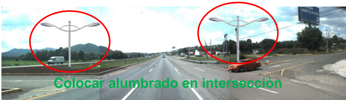
Figura 5.11 Mejorar la visibilidad en la Intersección mediante la colocación de alumbrado
