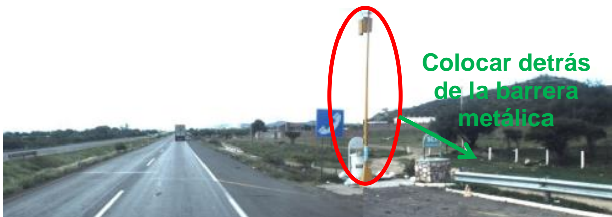
Figura 5.2 Medida de mejoramiento propuesta que consiste en reubicar el poste SOS detrás de la barrera
