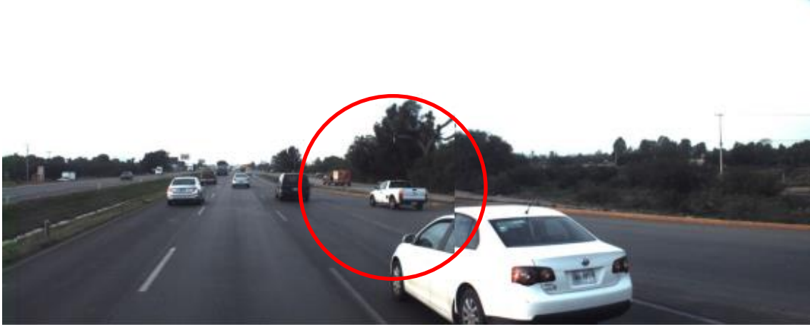
Figura 4.36 Carril de incorporación con longitud inadecuada (muy corto)
