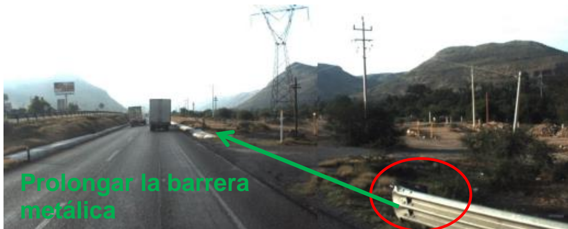
Figura 5.19 La medida de mejoramiento en los casos de accesos irregulares del lado derecho puede ser la prolongación de la barrera metálica
