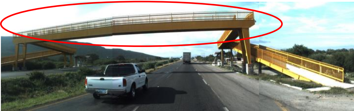
Figura 4.27 Falta de iluminación en cruce peatonal a desnivel
