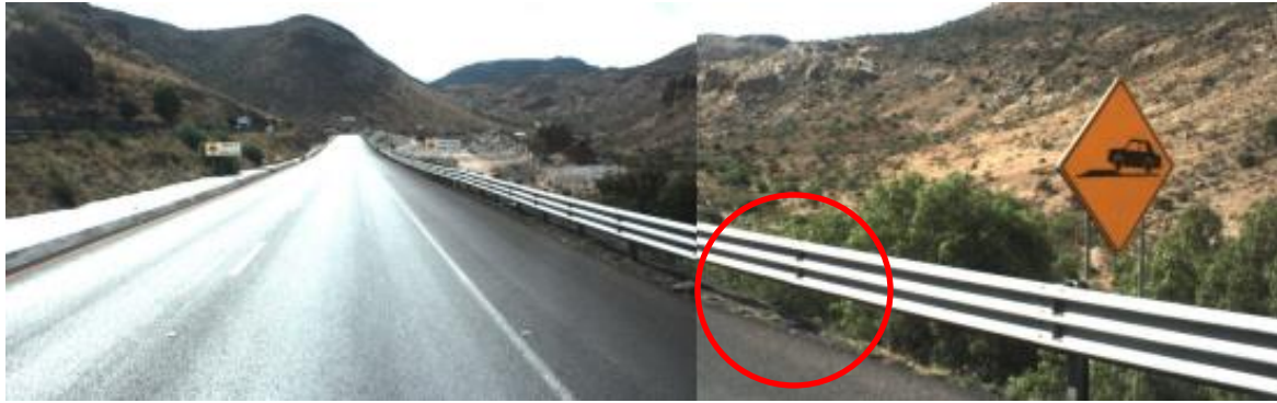
Figura 4.14 Falta de poste y separador en barrera metálica instalada
