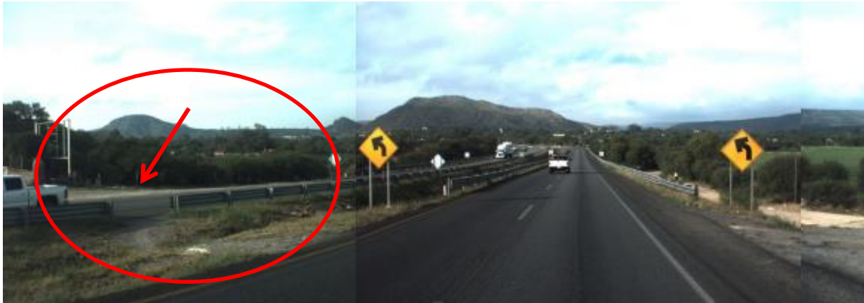
Figura 4.29 Infraestructura inexistente para cruce seguro de peatones
