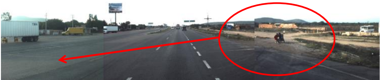
Figura 4.42 Acceso irregular que genera cruce de vehículos
