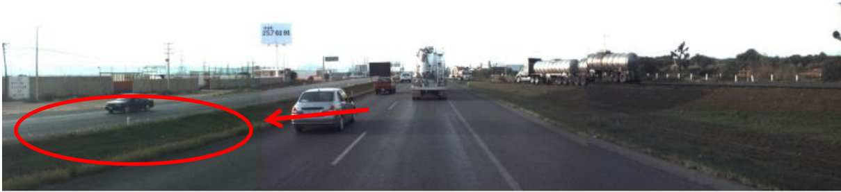
Figura 4.24 Escasa o nula anchura de acotamiento interno
