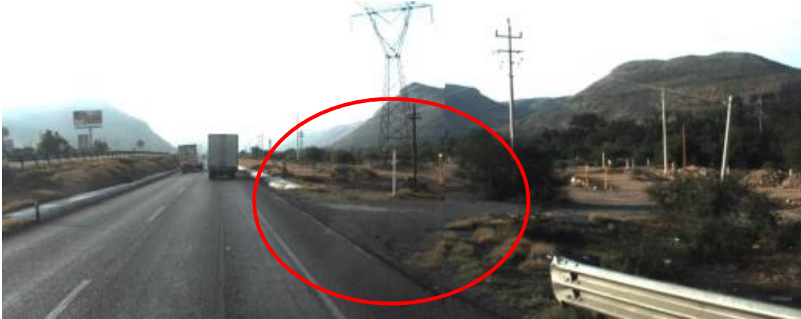
Figura 4.40 Acceso irregular del lado derecho de la vía
