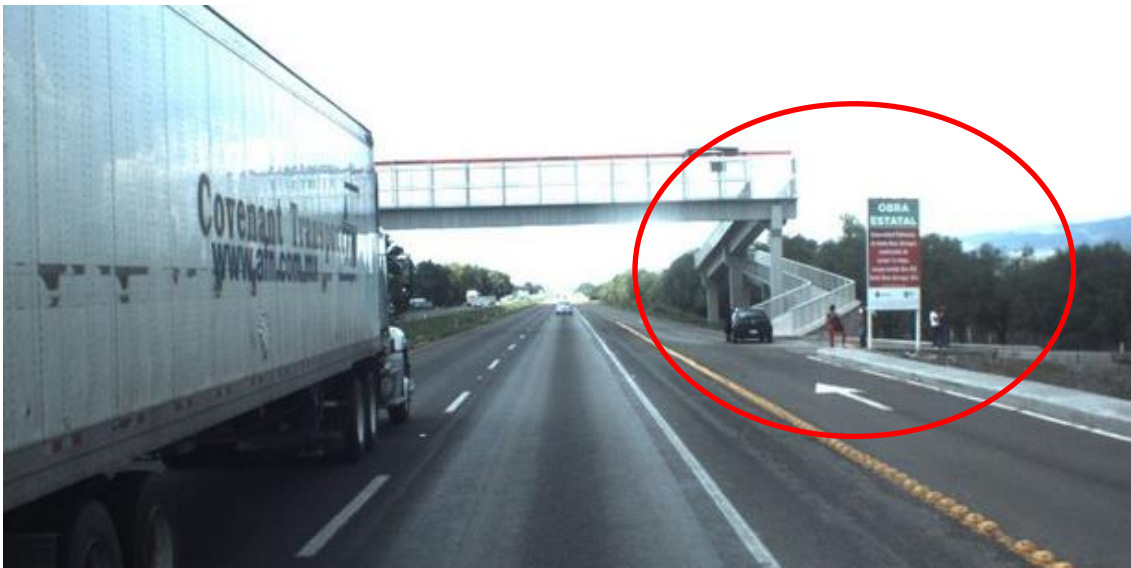
Figura 4.34 Zona escolar en tramo de alta velocidad sin infraestructura para disminuir velocidad y sin señalamiento
