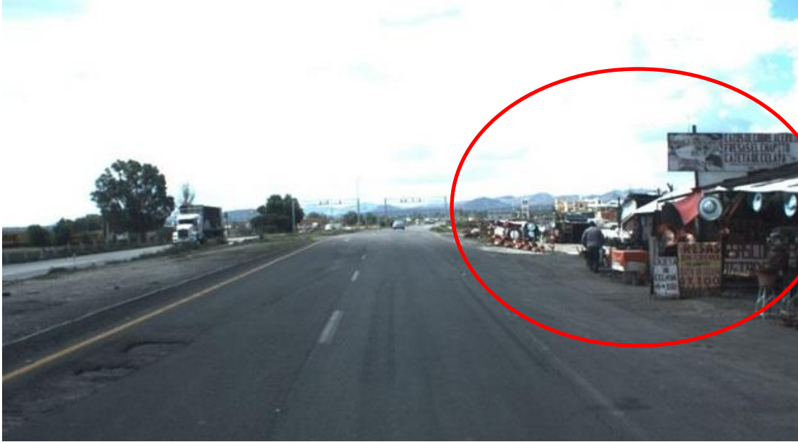
Figura 4.31 Cruce de peatones a nivel debido a zona comercial
