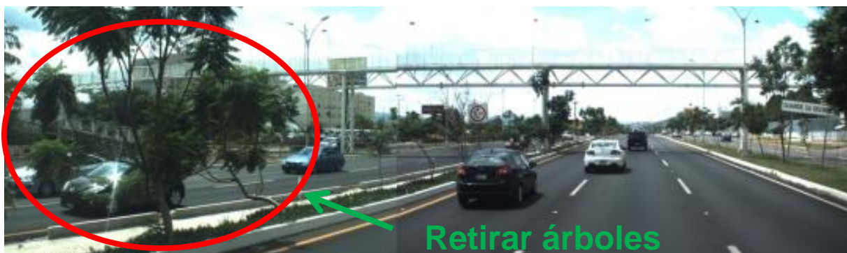
Figura 5.4 Medida de mejoramiento propuesta que consiste en eliminar los árboles que se encuentran muy cercanos a la vía
