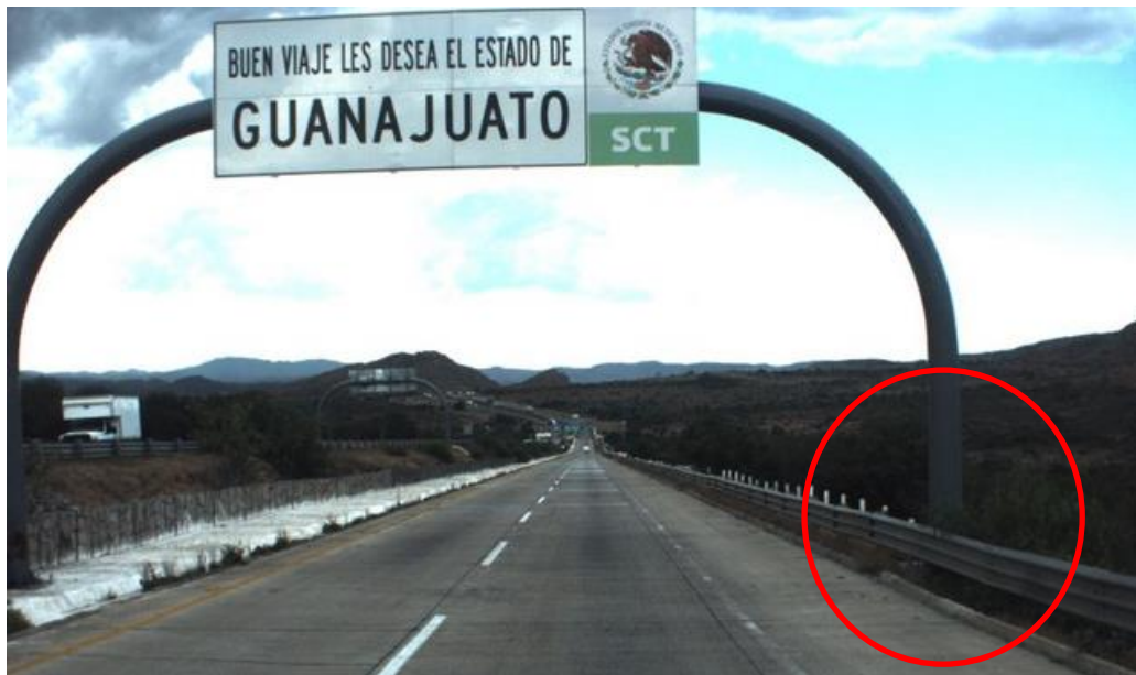
Figura 4.15 Presencia de barrera con ancho de trabajo insuficiente
