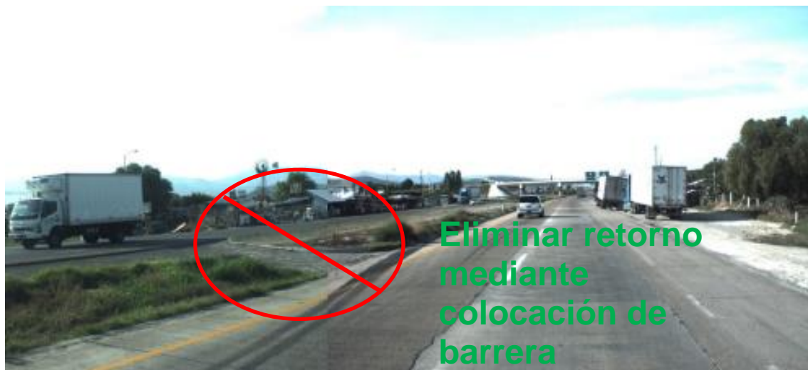
Figura 5.20 La medida de mejoramiento en los casos de accesos irregulares en la faja separadora central puede ser la colocación de la barrera metálica o de concreto
