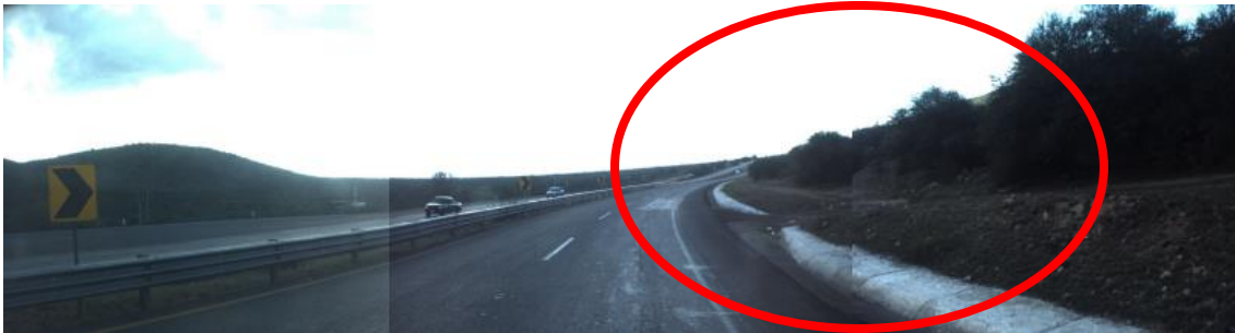
Figura 4.7 Acceso que representa un peligro en la vía
