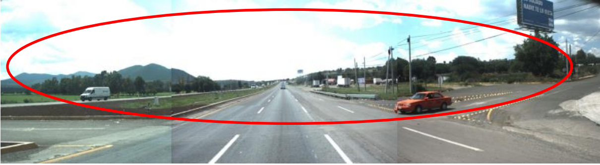
Figura 4.28 Falta de iluminación en intersección
