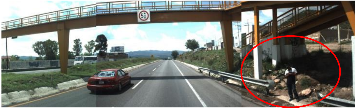
Figura 4.32 Cruce de peatones a nivel en puente peatonal
