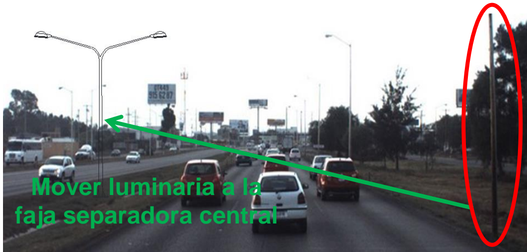
Figura 5.3 Medida de mejoramiento propuesta que consiste en mover la luminaria a la faja separadora central
