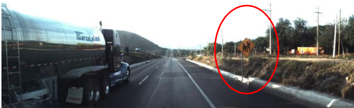
Figura 4.33 Señalización deficiente y falta de dispositivos de alerta de zona escolar
