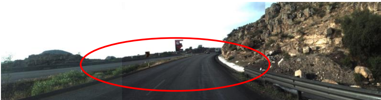
Figura 4.18 Falta de conservación de las marcas horizontales
