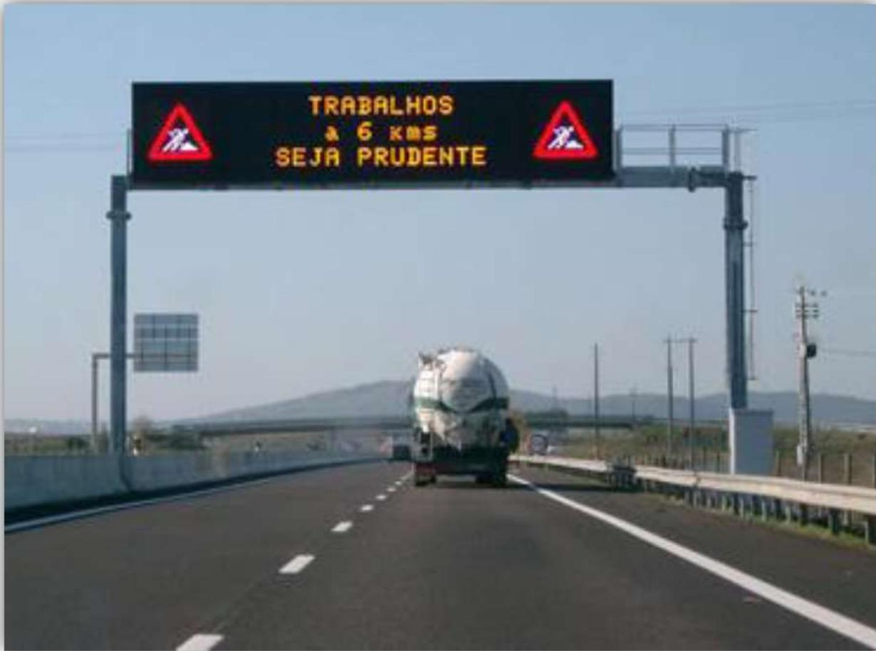
**Figura 3.25 Señal de mensaje variable**
