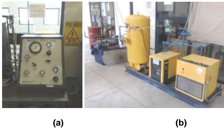
Figura 2.5. Panel de presión (a) y compresor para el suministro de aire (b).
