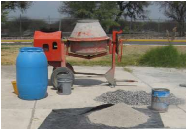
Figura 3.5 Trompo con los elementos para mezclar y elaborar el concreto de las muestras
