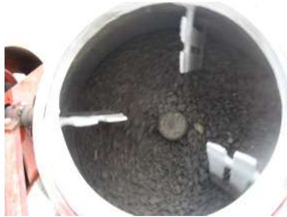
Fotografía 3.6 Trompo revolviendo la mezcla de concreto
