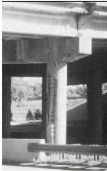
a) Exposición a sales de deshielo ataque desde la parte superior
