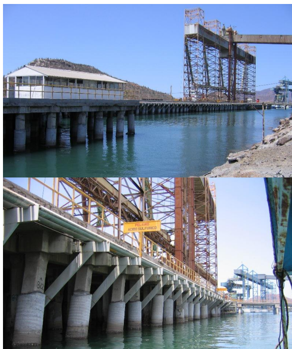
Figura 1.6 Vista desde tierra del tramo 6, con la estructura para carga/descarga de granos y línea de conducción de ácido sulfúrico.
