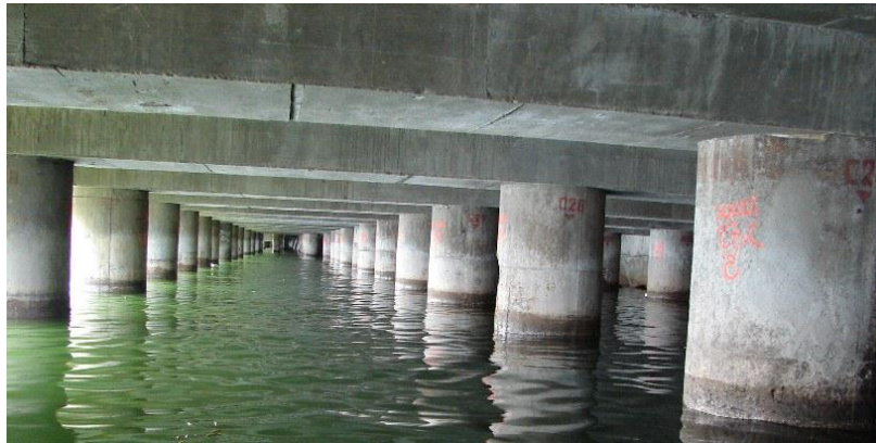
Figura 1.4 Pilas circulares y traveses de soporte del tramo 2 del muelle API GUAYMAS.
