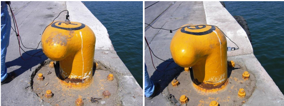
Figura 2.9 Ubicación de acelerómetro sobre la vita durante medición de vibraciones
