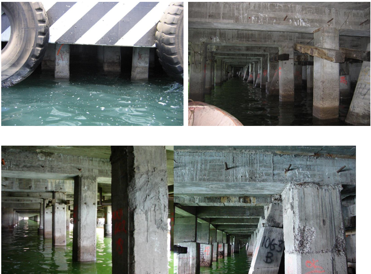
Figura 1.5 Ejemplo de pilotes de soporte de la losa en muelles 3 a 6.
