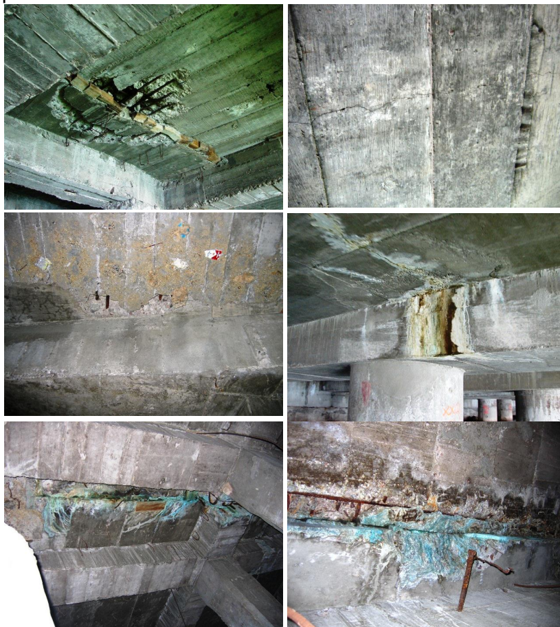
Figura 4.2 Grietas, fisuras y defectos promotores de filtraciones y deterioro en losa
