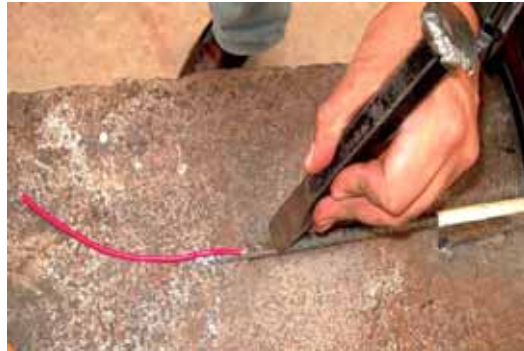
Figura 3.7 Introducción y sujeción del cable a la varilla
