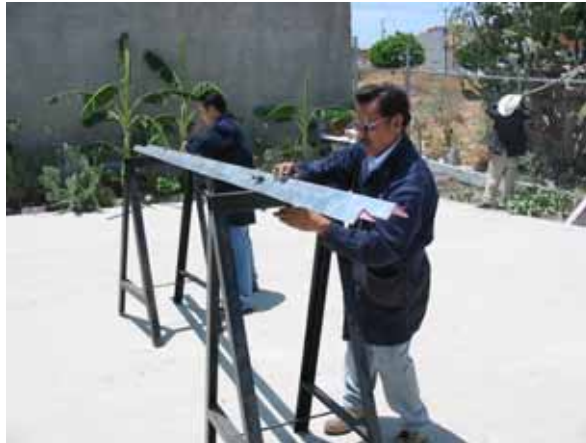
Figura 3.34 Instalación de la Estación de Campo, Querétaro (Mx8)
