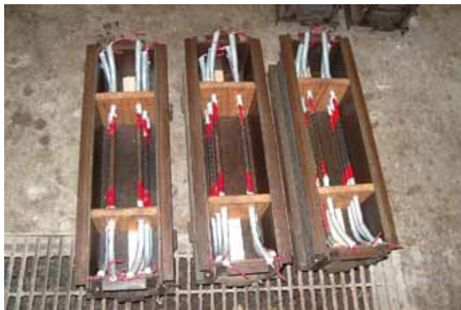
Figura 3.17 Varillas colocadas en los moldes
