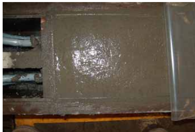
Figura 3.24 Colocación de una membrana plástica para evitar pérdida de humedad
