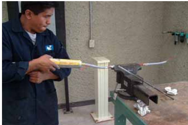
Figura 3.15 Inyección del producto elastomérico
