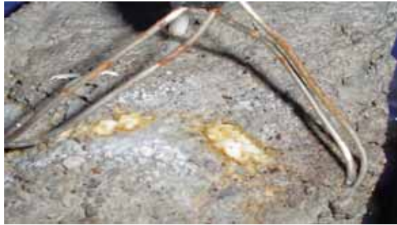
Figura 28 Productos de corrosión del ánodo de sacrificio
