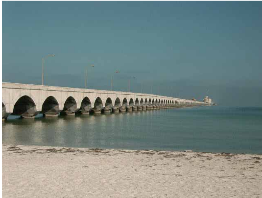
Figura 1.4 Vista del muelle de Progreso.
