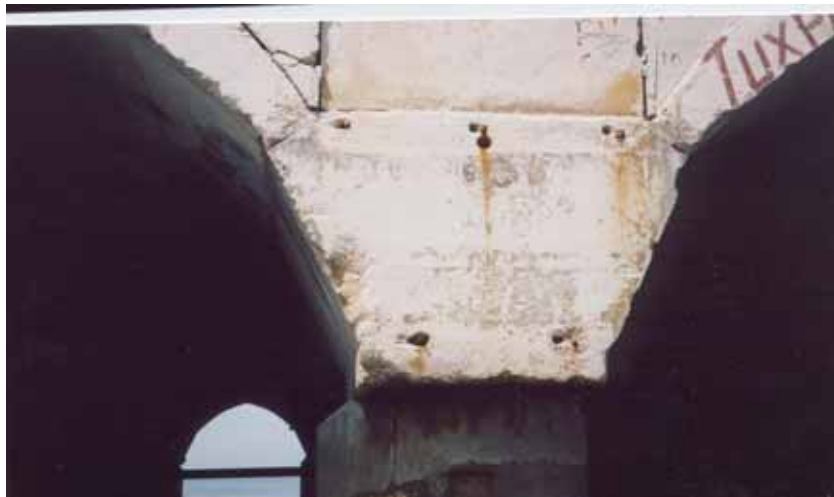
Figura 1.5 Detalle del cabezal donde se muestran cinco de las barras
