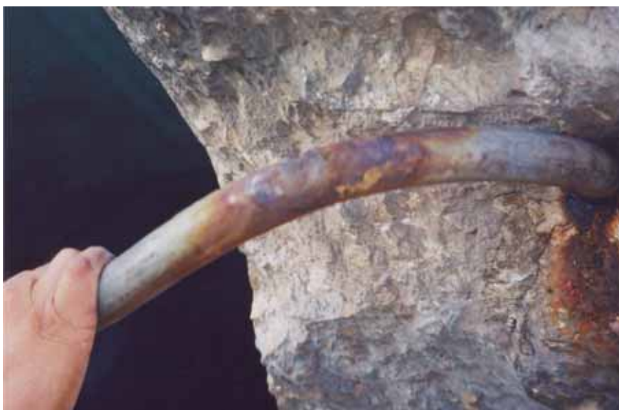
Figura 1.6 Detalle de una de las barras expuestas (fuera del concreto), en donde se observa corrosión en el gancho o dobles
