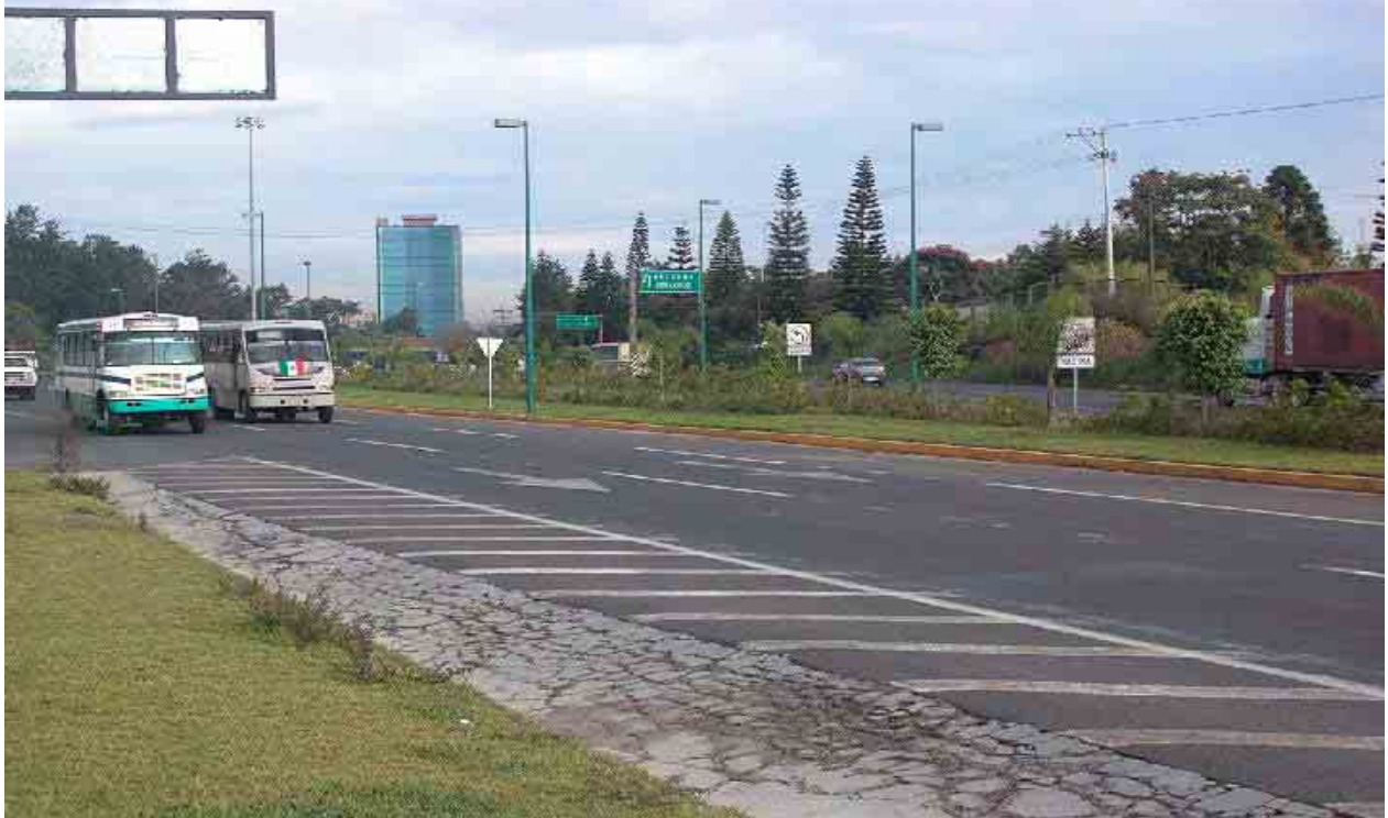
Figura 6.17 Condiciones de la carretera
