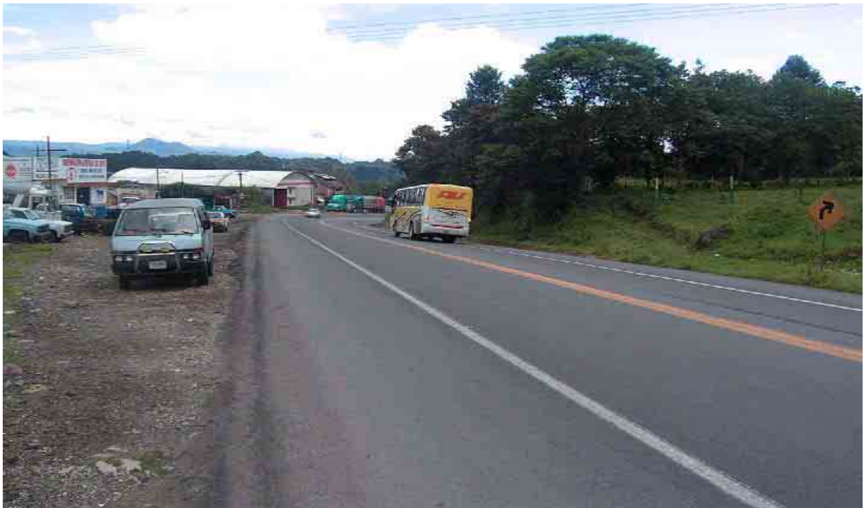
Figura 6.20 Condiciones de la carretera
