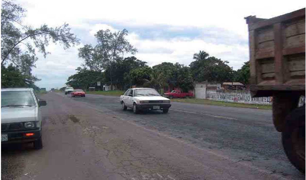
Figura 6.14 Condiciones de la carretera
