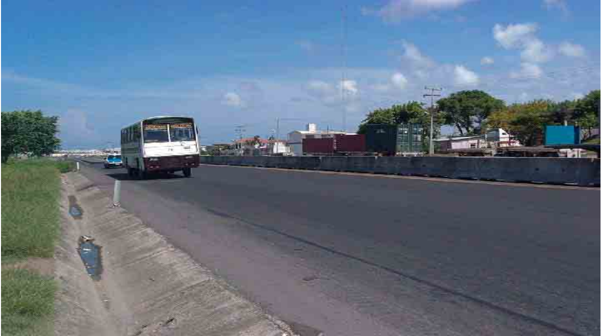
Figura 6.11 Condiciones de la carretera
