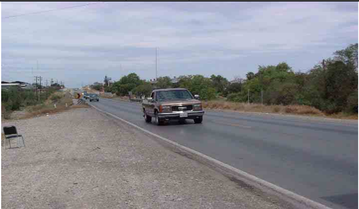
Figura 6.20 Condiciones de la carretera
