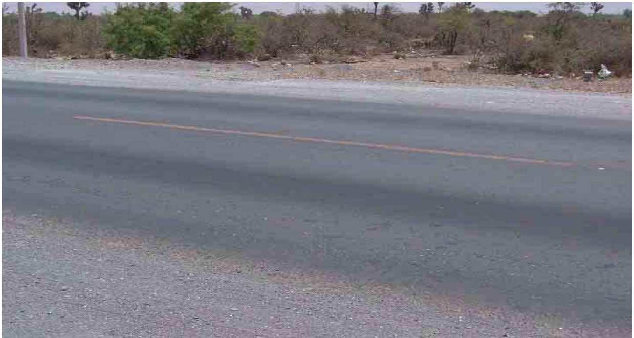
Figura 6.8 Condiciones de la carretera
