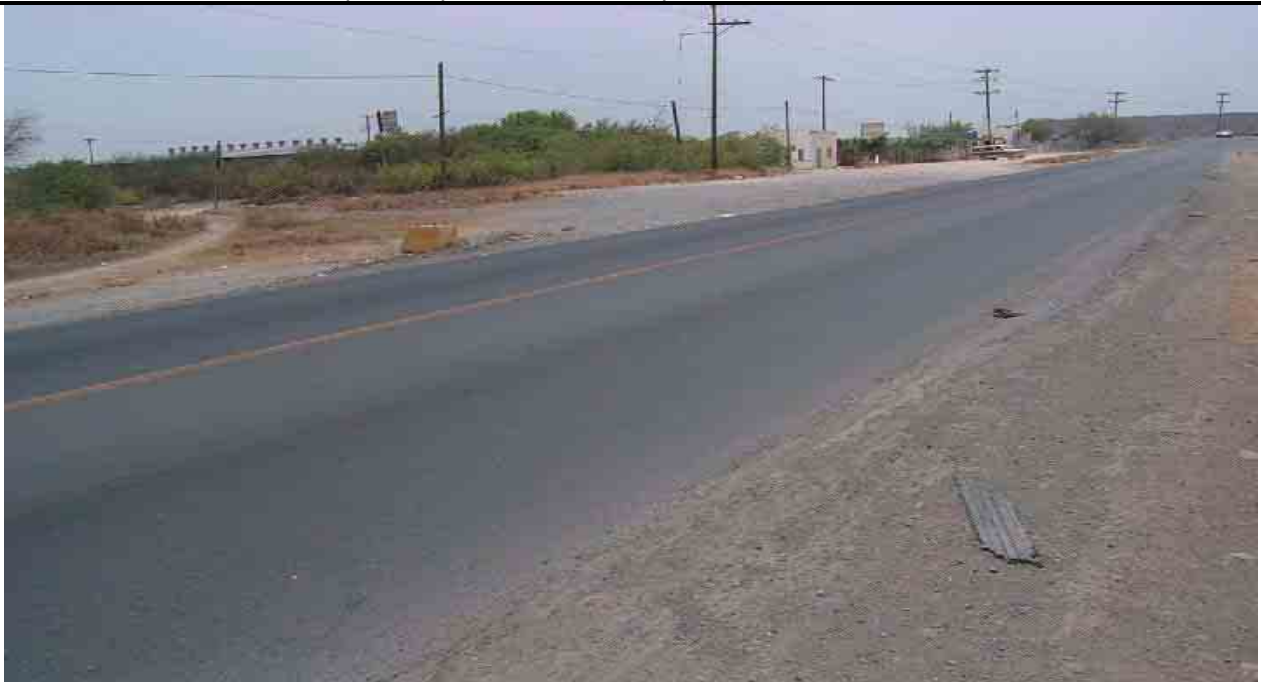
Figura 6.14 Condiciones de la carretera
