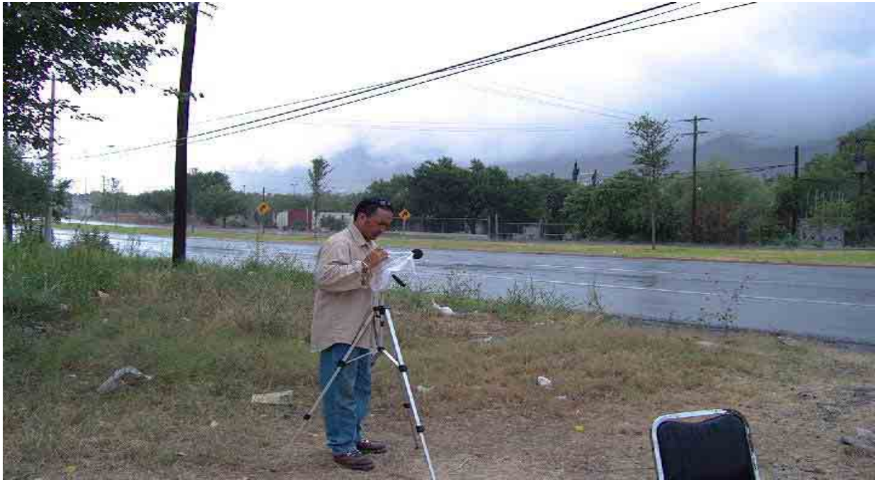
Figura 6.17 Condiciones de la carretera
